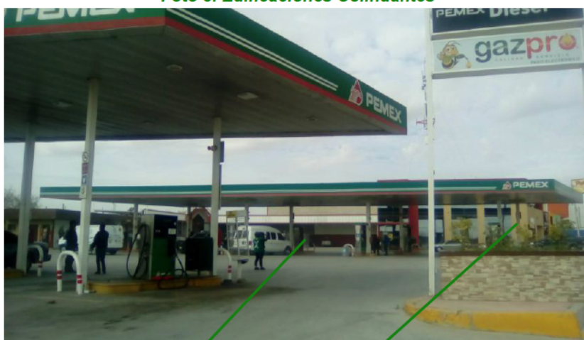
Bodegas y Edificios Habitacionales
