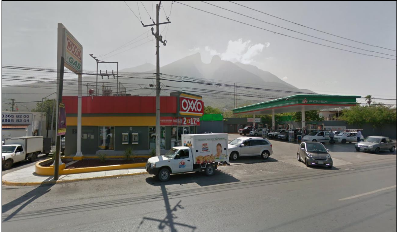
Figura 3. Tienda de conveniencia dentro de la estación de servicio.
