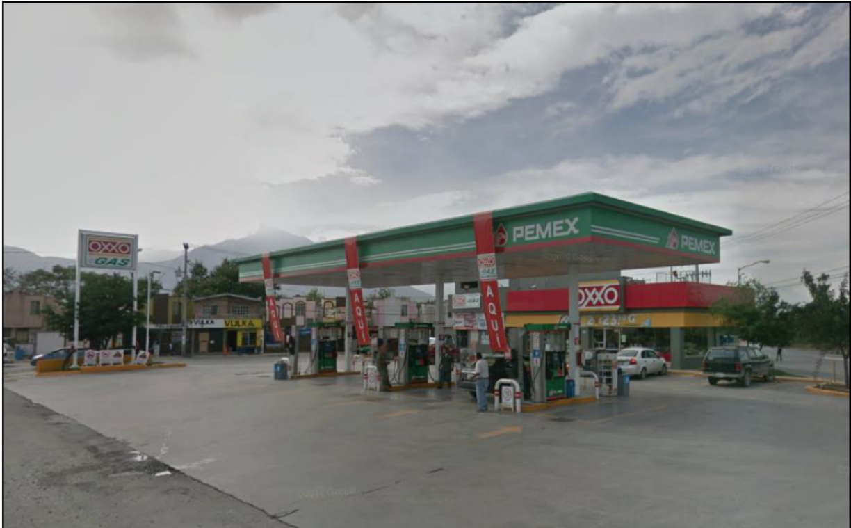
Figura 1. Vista general de las instalaciones de la estación de servicio.
