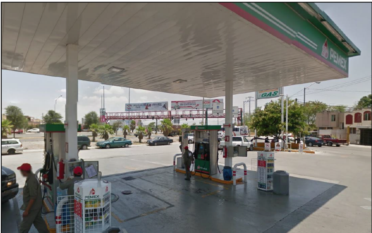
Figura 2. Área de despacho de la estación de servicio.
