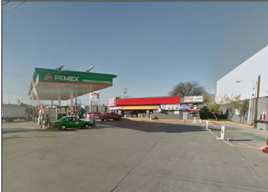
Figura 1. Vista general de las instalaciones de la estación de servicio.
