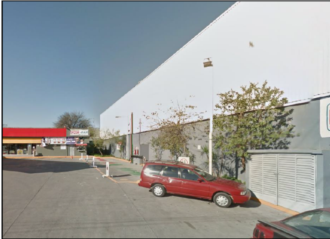
Figura 3. Área de tanques de la estación de servicio.
