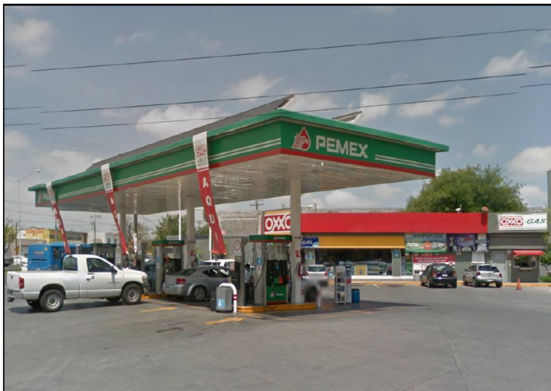
Figura 2. Área de despacho de la estación de servicio.
