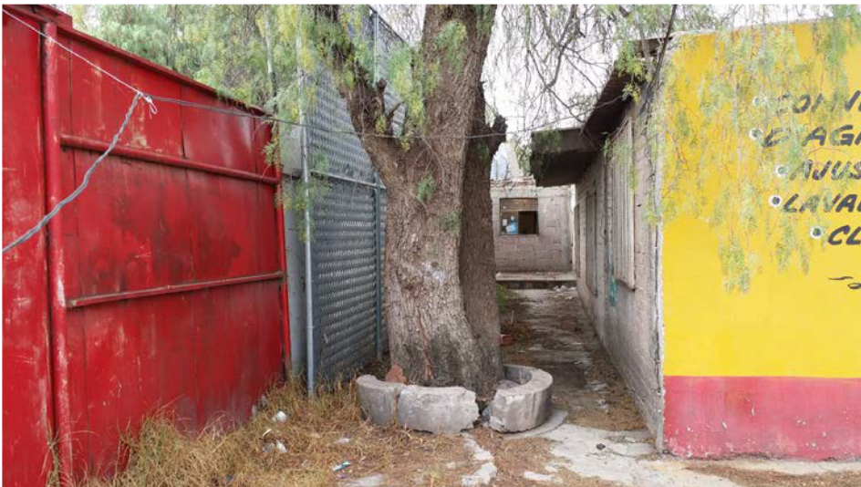
Foto 4 Acercamiento al área en donde se encuentra el ejemplar de pirul, se observa un corredor completamente cubierto de piso de concreto en el perímetro del lindero se tiene estrato herbáceo, las construcciones: muros y ventanas. , malla ciclónica).
