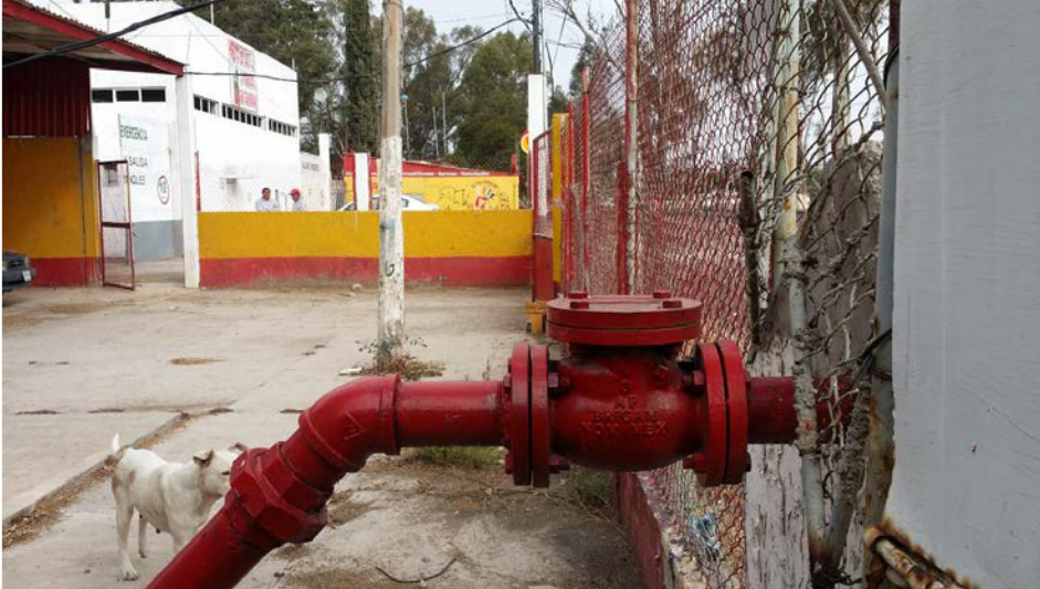
Foto 5 Condiciones ambientales al interior del predio, completamente desprovisto de vegetación.
