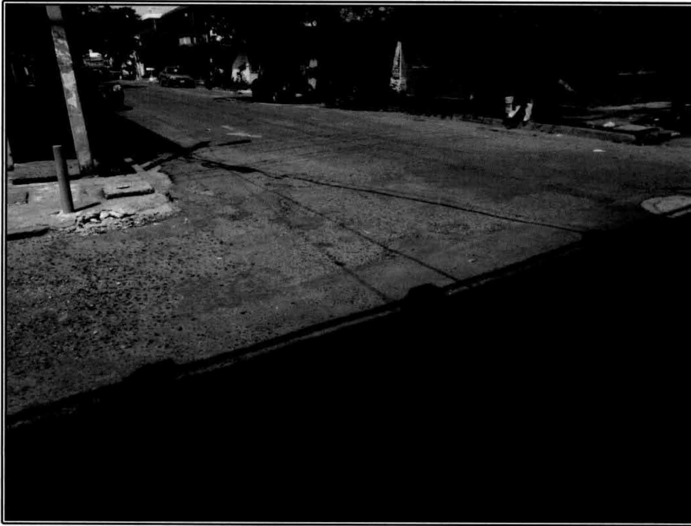
Foto VIII.1 Punto de interconexión con el gasoducto de 20" D.N. mediante la instalación de la ER 1.
