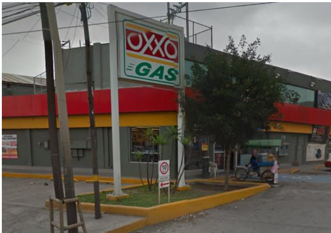
Figura 4. Área verde de la estación de servicio.
