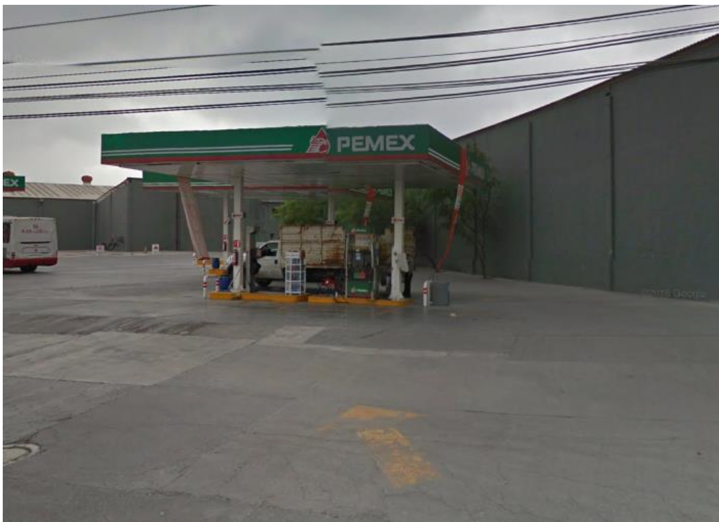
Figura 2. Área de despacho de la estación de servicio.
