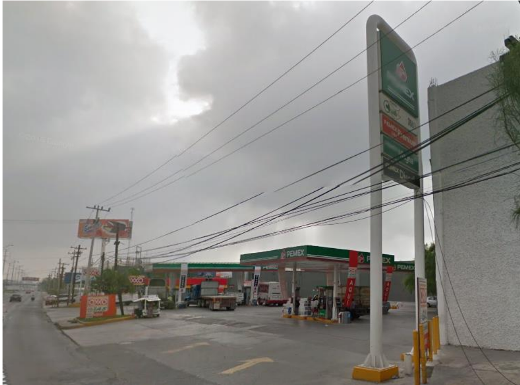
Figura 1. Vista general de las instalaciones de la estación de servicio.
