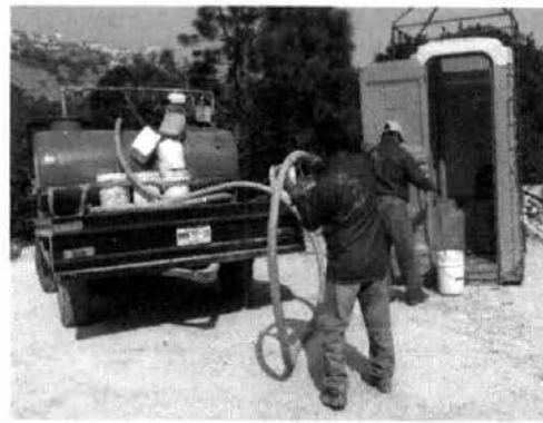
Fotografía 4. Acciones de limpieza y recolección de aguas residuales de sanitarios portátiles.
