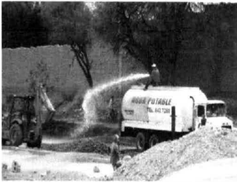
Fotografía 1. Suministro por medio de pipas de agua para evitar emisiones de partículas suspendidas en el predio.
