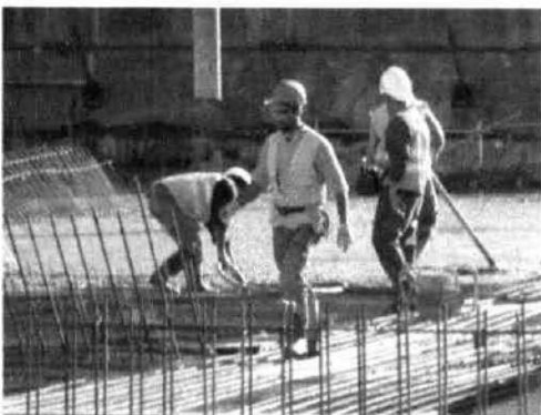
Fotografía 7. Trabajadores con equipo de protección y su uso correcto.
