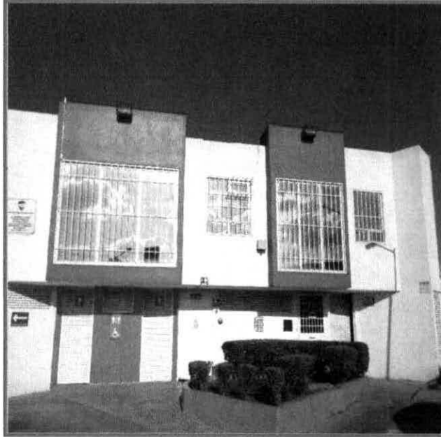
Fotografía 3. La estación de servicio cuenta con sanitarios públicos y un área administrativa de dos plantas.
