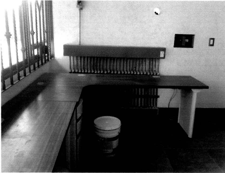
Vista de las condiciones actuales del Cuarto Eléctrico
