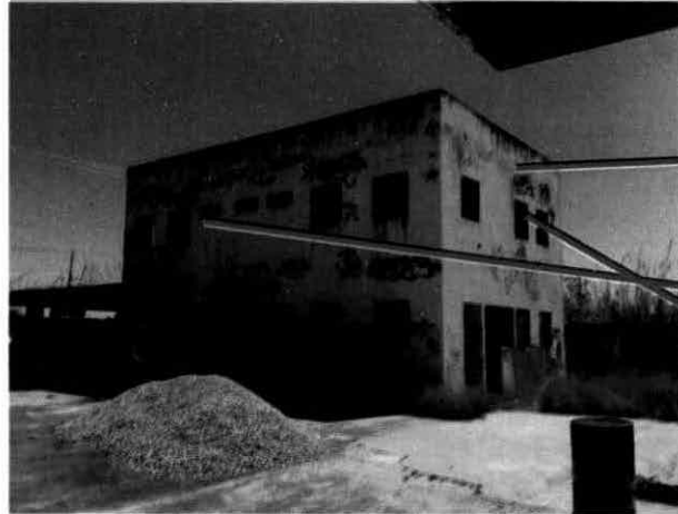
Edificio de la estación de servicio, barda perimetral de tabique y piso de concreto
