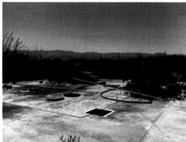
Área de tanques tapado con concreto
