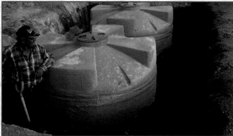
Figura 9: Imágenes del avance de la construcción.
