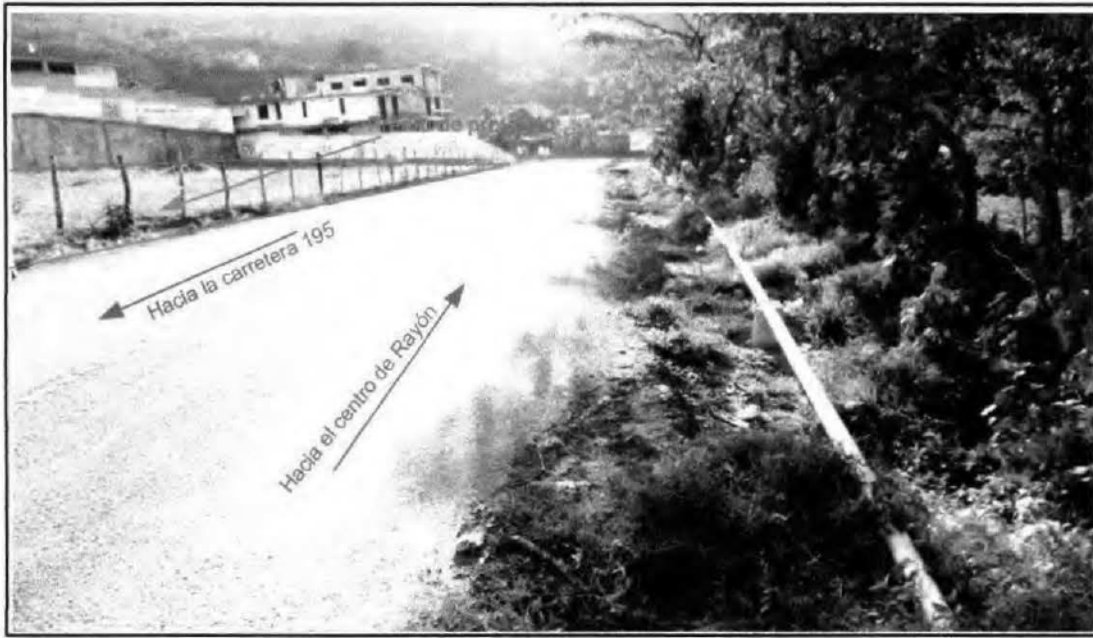
IMAGEN 1 .- VISTA EN DIRECCIÓN NOROESTE EN DONDE SE APRECIA LAS CONDICIONES DE LA CARRETERA CENTRAL, COLINDANCIA NORTE DEL PREDIO Y EL FRENTE DEL PREDIO.
