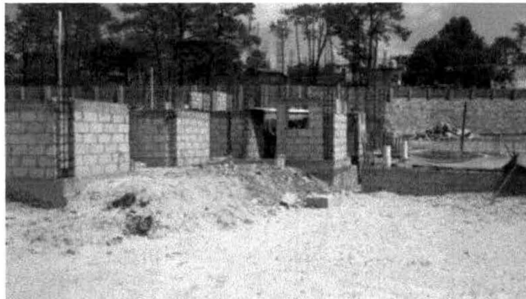
Vista de obras de la gasolinera (área administrativa, local comercial, sanitarios) que se habian iniciado.
