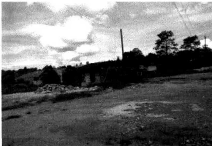
Vista de la construcción existente en el predio que fue demolida en el área que ocupará la edificación de la Estación de Servicio.
