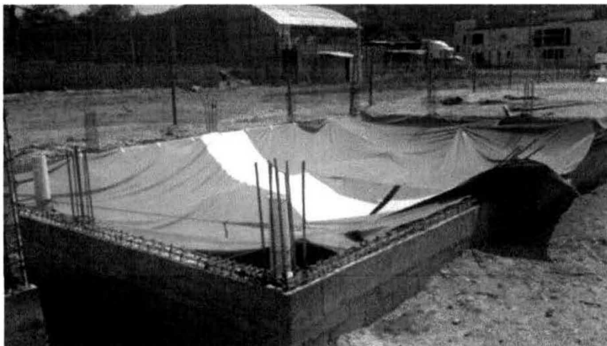
Vista de obras de la Estación de Servicio que se habían iniciado
