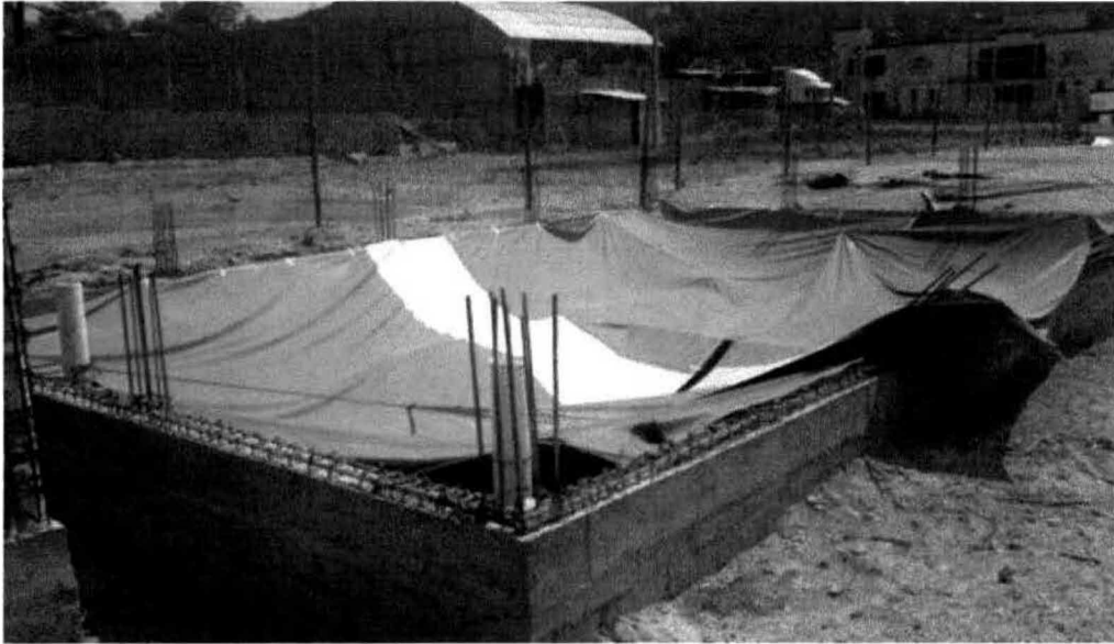
Vista de obras de la gasolinera (área de tanques) que se habían iniciado
