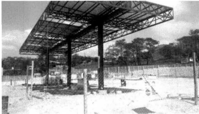
Vista de obras de la gasolinera (área de dispensarios) que se iniciaron y que dieron origen al procedimiento administrativo instaurado por PROFEPA.
