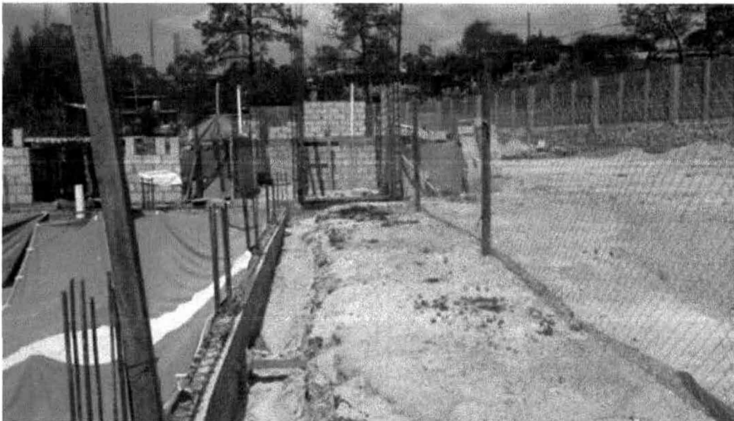
Instalaciones que iniciaron su construcción y que dio origen al procedimiento administrativo instaurado por la PROFEPA.
