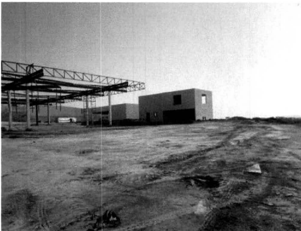
Figura 2.- Obra civil destinada a oficina y tienda de conveniencia.
