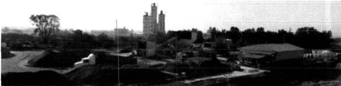
Figura 31 .- Vista este del predio .Compañía CEMEX
