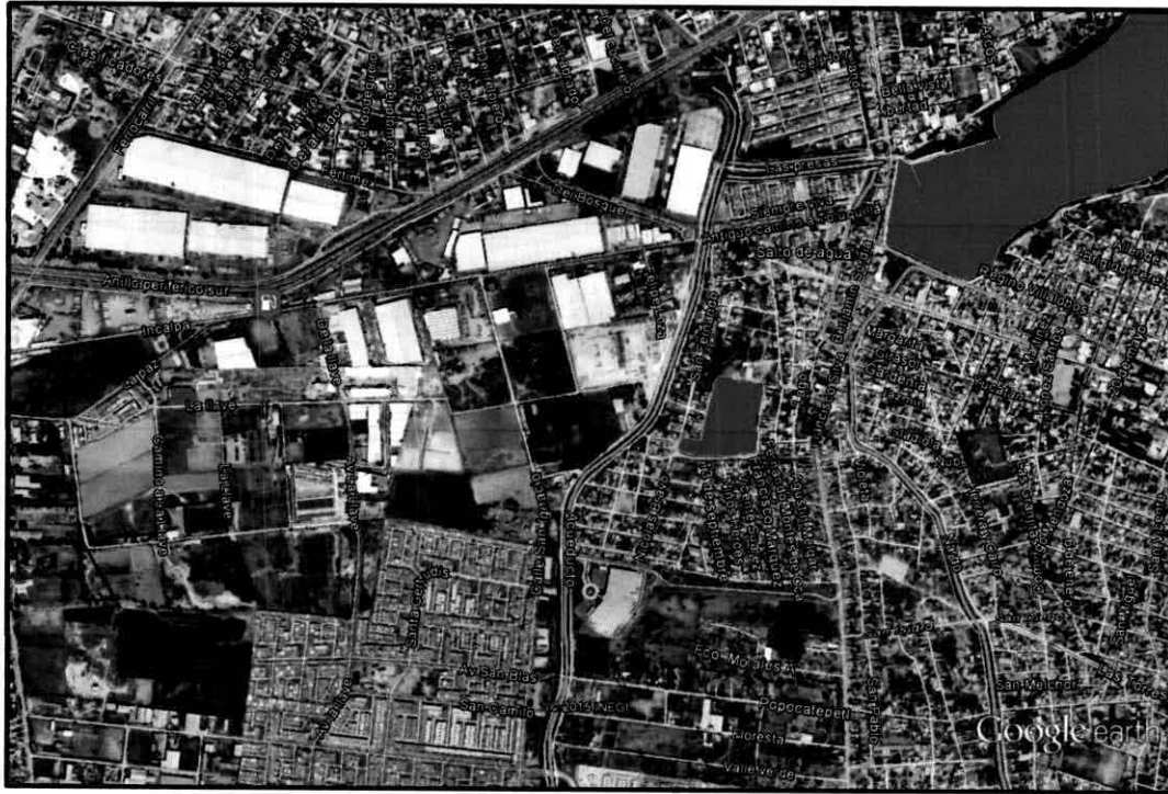
Figura 13. Canales de conducción y vasos reguladores de la zona. El polígono de mayor área representa la ubicación de la Presa Las Pintas.
