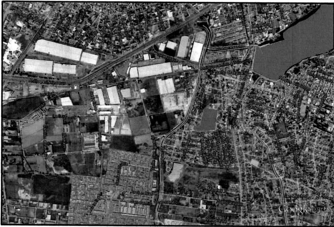
Figura 56. Canales de conducción y vasos reguladores de la zona. El polígono de mayor área representa la ubicación de la Presa Las Pintas.
