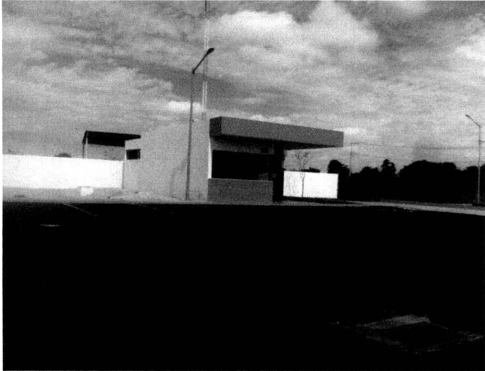
7.-Actualmente en esta parte se observan la oficina administrativa y los baños de la estación de servicio No.12862, así como las rejillas del drenaje pluvial y los espacios para estacionamiento.
