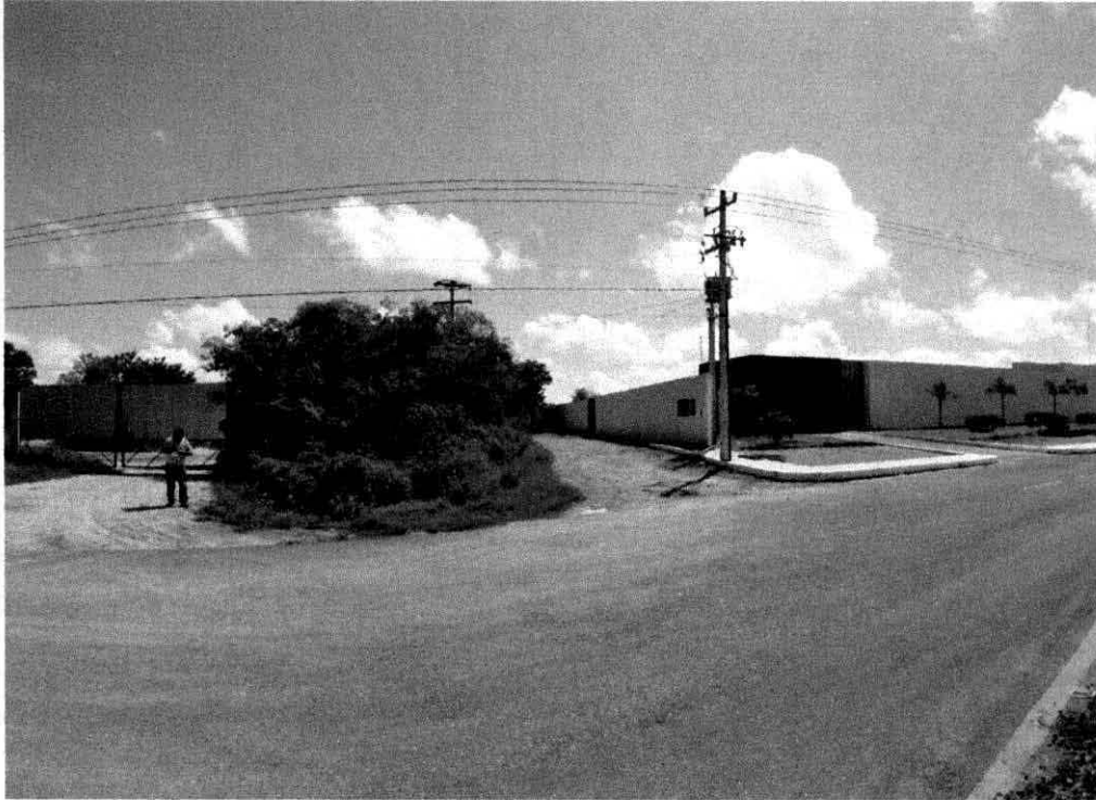
11.-Para el mes de septiembre 2014 así se encontraba la colindancia sur, se observa a la izquierda el predio del proyecto con una reja verde, posteriormente una calle de terracería y a la derecha se encuentra el motel Golden Suites
