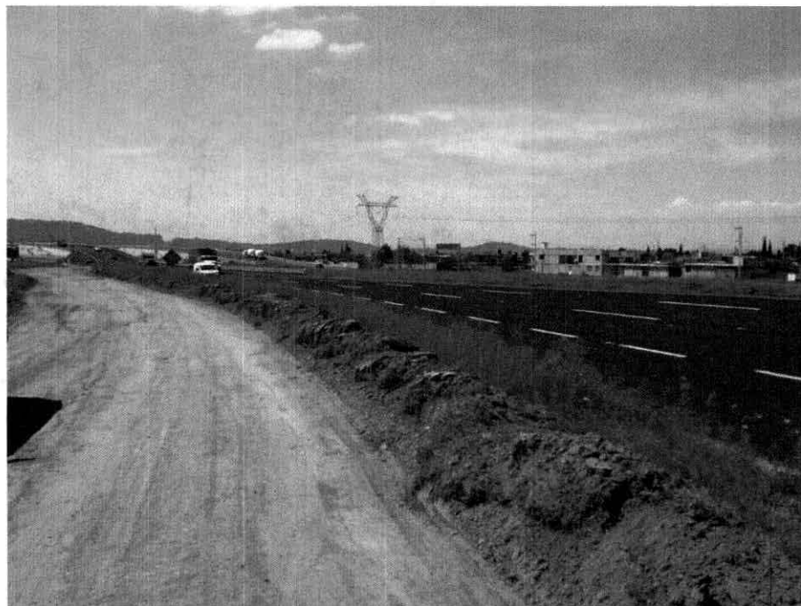
Fotografía 4 Vista lateral del proyecto
