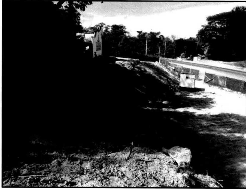
Fotografía 5. Condiciones actuales de la sección Oeste del interior del predio donde se pretende instalar la Estación de Servicio.
