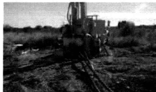
Se presenta otra de las pruebas de penetración estándar realizadas durante la exploración del sondeo N°2, observando las barrenas espirales colgadas, durante dicho muestreo.
