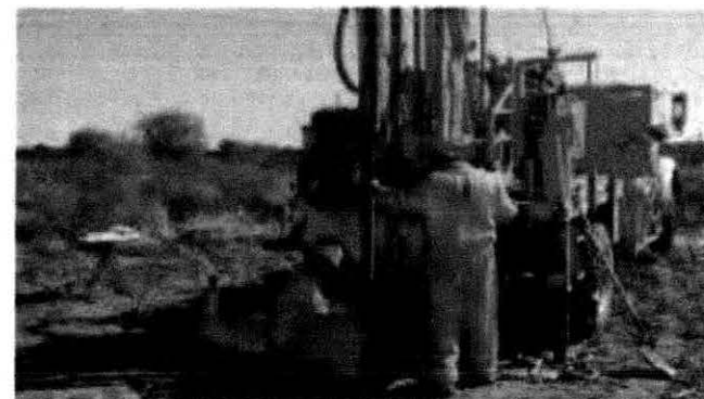
Se presenta la ejecución del muestreo alterado mediante la prueba de penetración estándar de acuerdo a la Norma ASTM D 1586 en el sondeo N°1.
