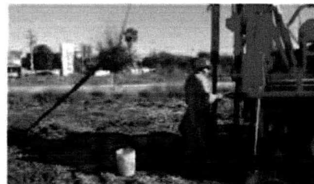
Se presenta la ejecución del muestreo alterado mediante la prueba de penetración estándar, realizada de acuerdo a la Norma ASTM D 1586.
