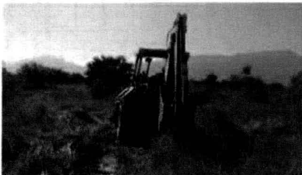
Se presenta la retroexcavadora utilizada para la ejecución de los accesos hasta los puntos de exploración, apreciando la vegetación existente.
