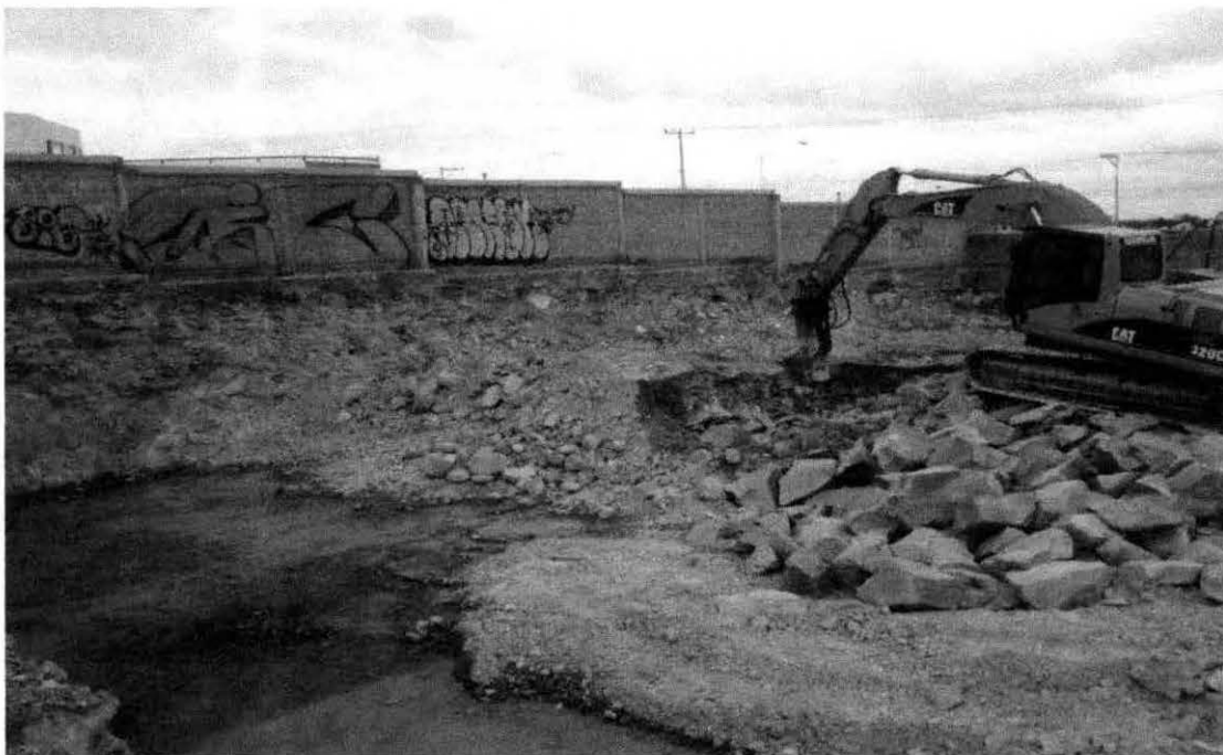
Ilustración 15 Espacio y trabajos donde se ubicaran los Tanques de Almacenamiento
