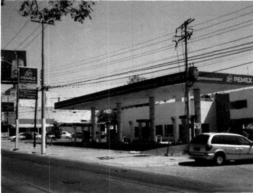
Figura 1. Estación de servicio "Superestación Patria Tepeyac S.A. de C.V.". Fuente: SAP Servicios Ambientales Profesionales.
