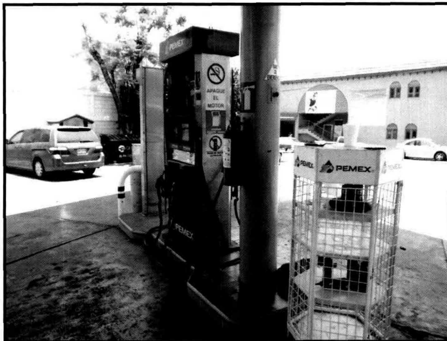
Imagen 2. La estación cuenta con las medidas de seguridad correspondientes (botón de paro de emergencias, extintores)
