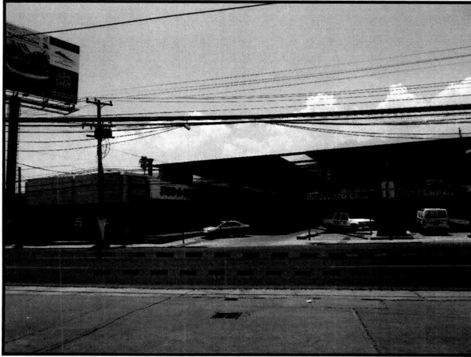
Imagen 3. Colindancia sur del proyecto calle Hidalgo y plaza comercial.
