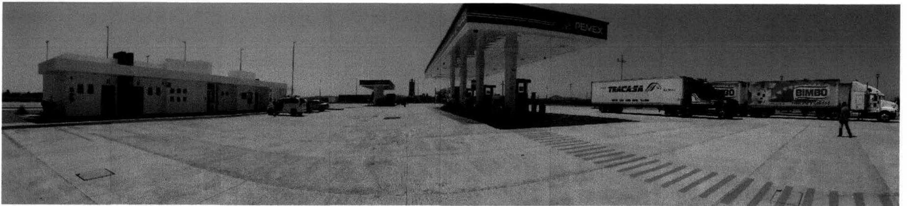
VISTA PANORAMICA, A LA IZQUIERDA BAÑOS, REGADERAS, CUARTOS DE MAQUINAS Y SUCIOS Y OFICINAS. AL CENTRO ÁERA DE DESPACHO DE GASOLINAS.
