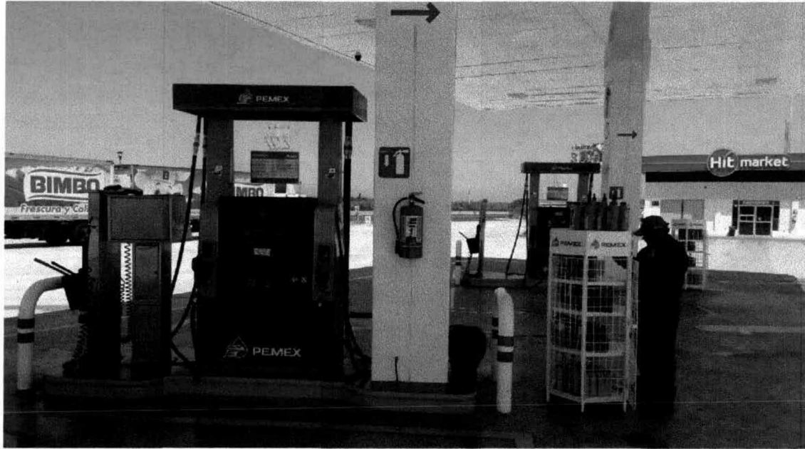
VISTA DISPENSARIO DE GASOLINAS.
