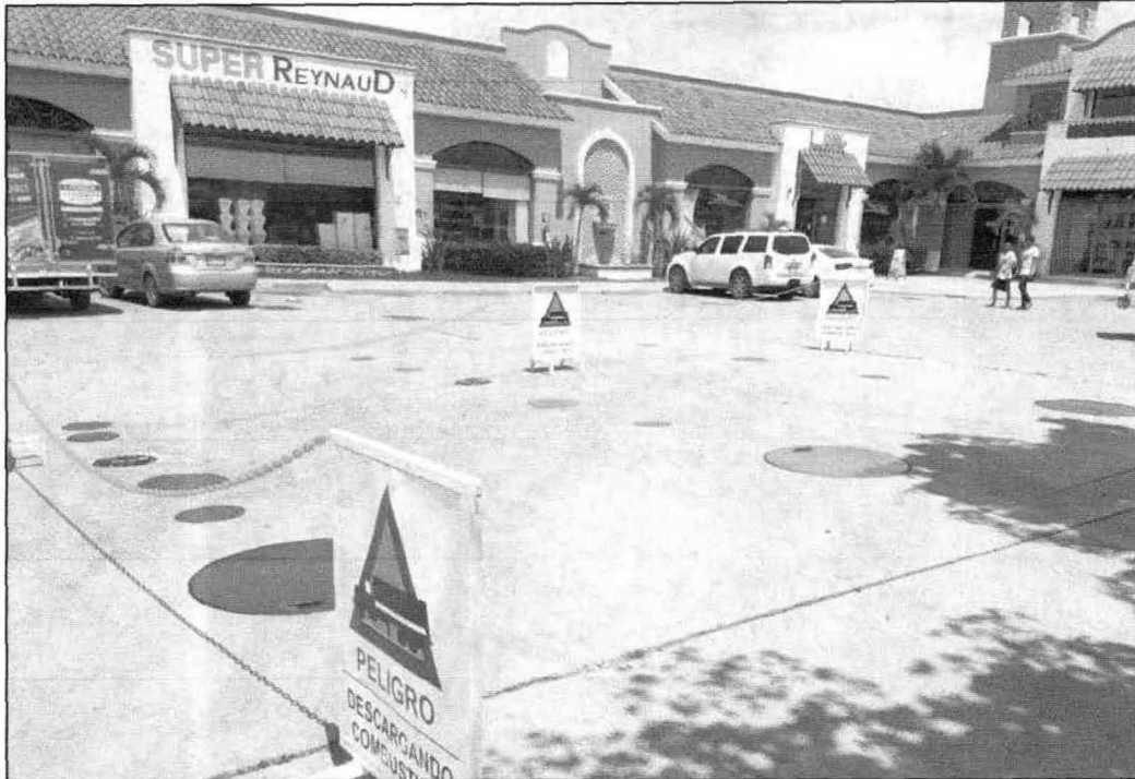
Fotografía 9. Área de tanques de almacenamiento.
