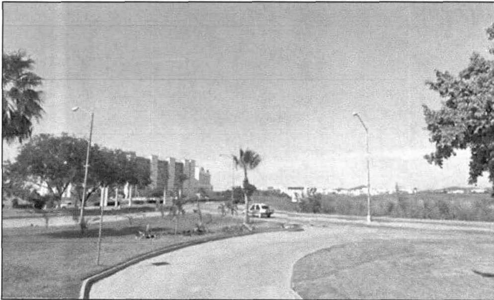
Fotografía 12. Visibilidad de la Estación de Servicio No. 9326.
