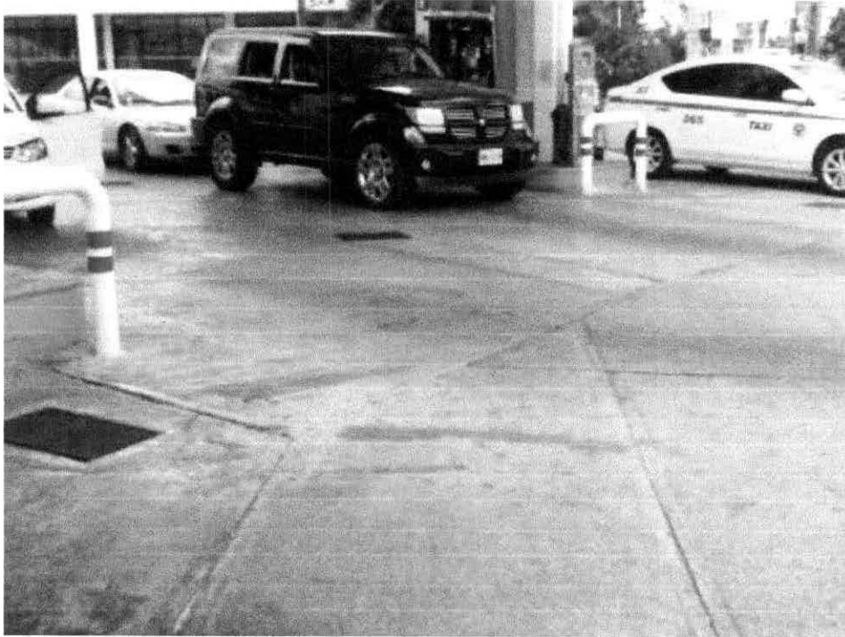
Figura 9. Rejillas para captación agua pluvial.
