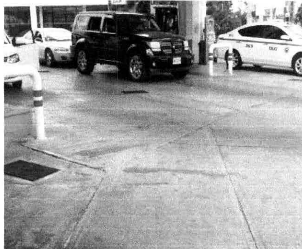
Figura 25. Panorámica mostrando rejillas del drenaje pluvial.
