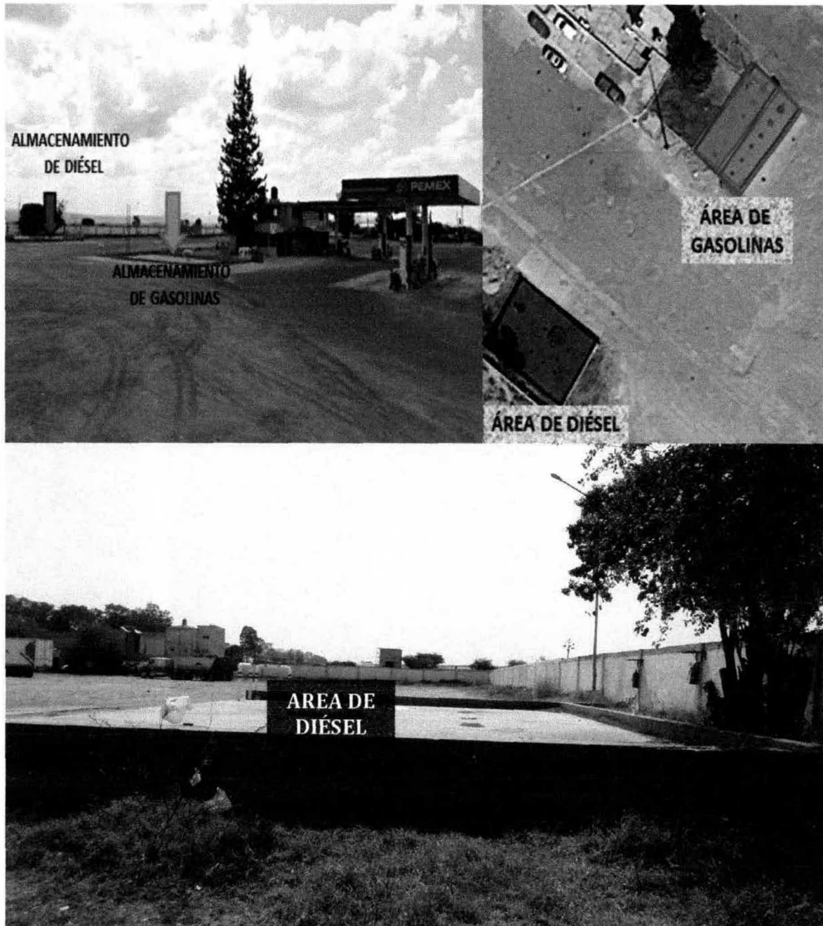
FIGURA 9. ÁREAS DE ALMACENAMIENTO DE COMBUSTIBLES
