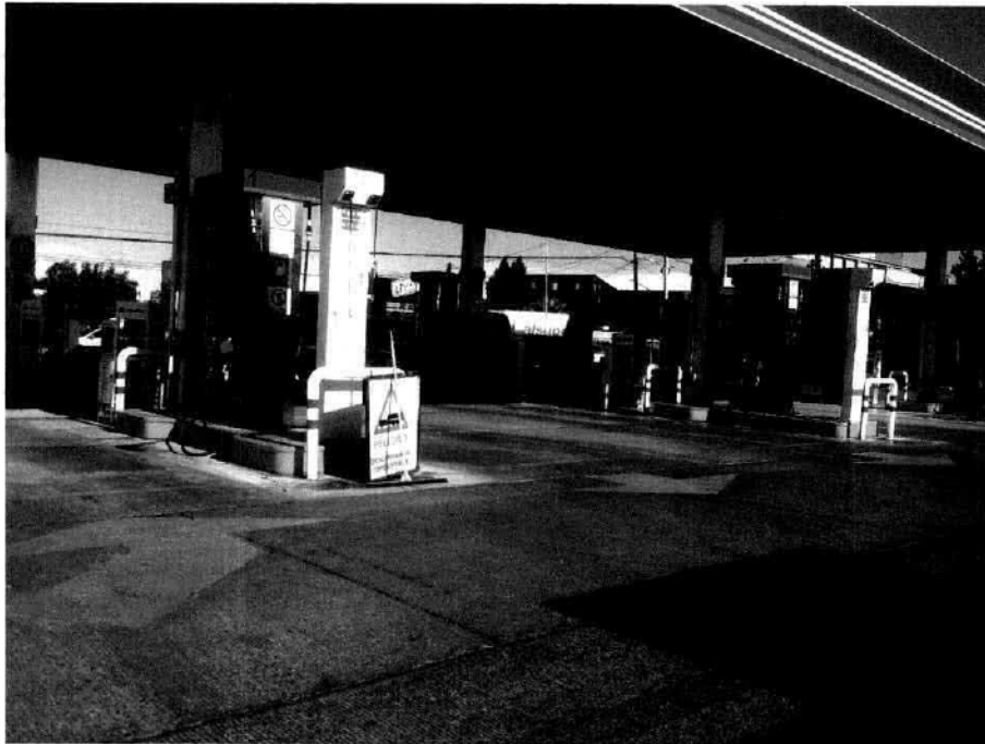
Imagen 2. Interior de la estación de servicio. Se aprecian los dispensadores, la techumbre y la señalética necesaria.
