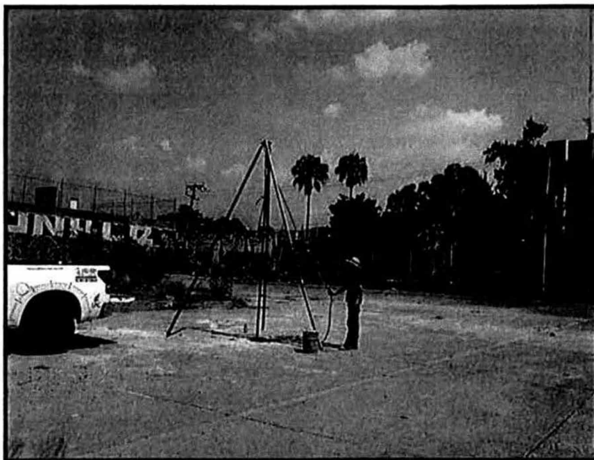
Fotografía 3: Vista general del predio.
