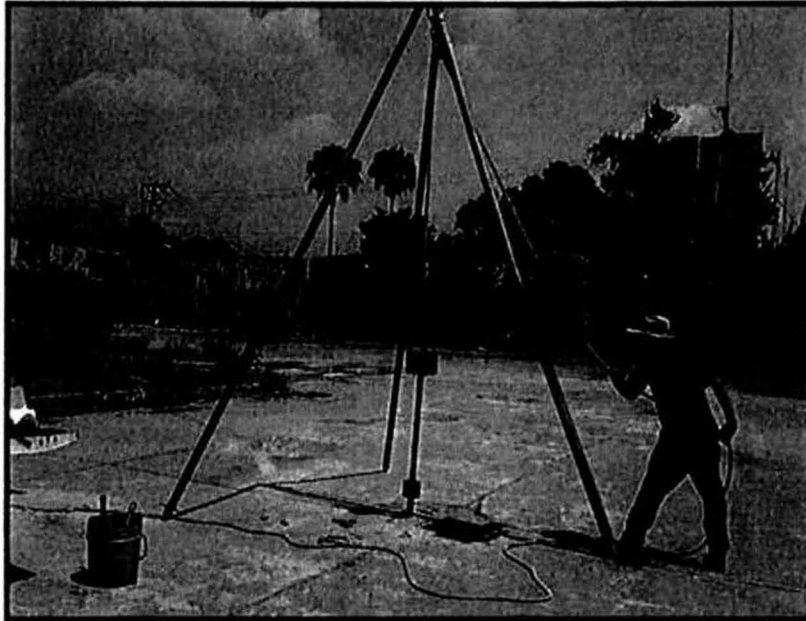
Fotografía 1: Realización del nuevo sondeo.
