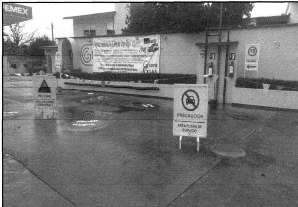
Fotografía 6. Zona de Tanques y medidas de seguridad.
