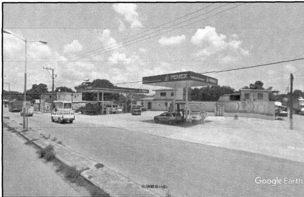
Fotografía 2. Vista panorámica de la estación de servicios.
