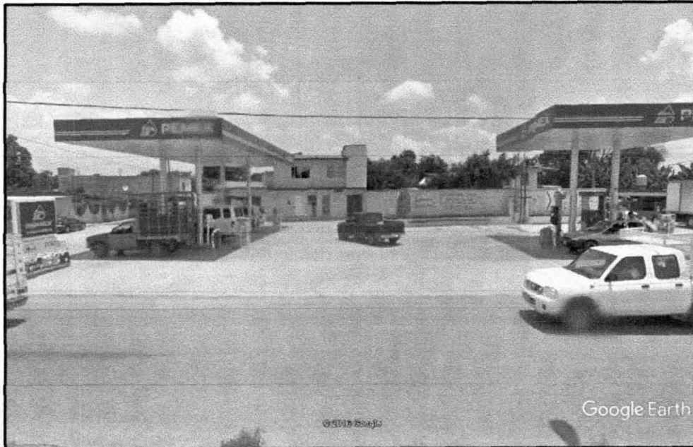
Fotografía 1. Vista del frente de la Estación de Servicio.
