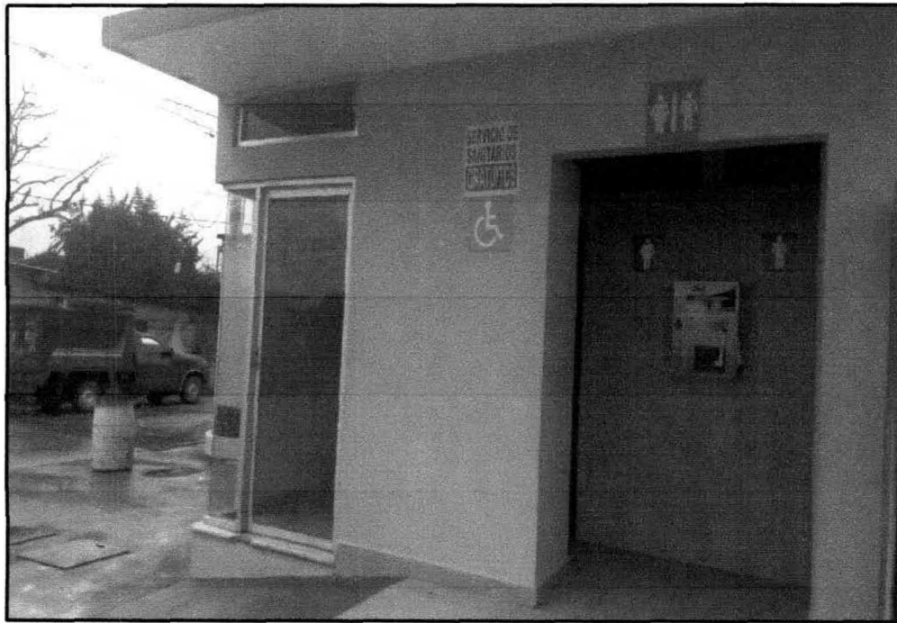
Fotografía 4. Área de baños.
