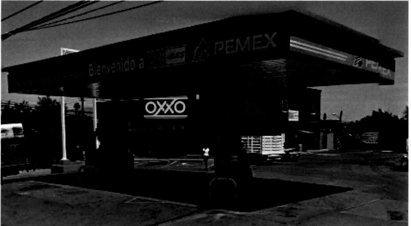
Figura 1. Vista general de las instalaciones de la estación de servicio.
