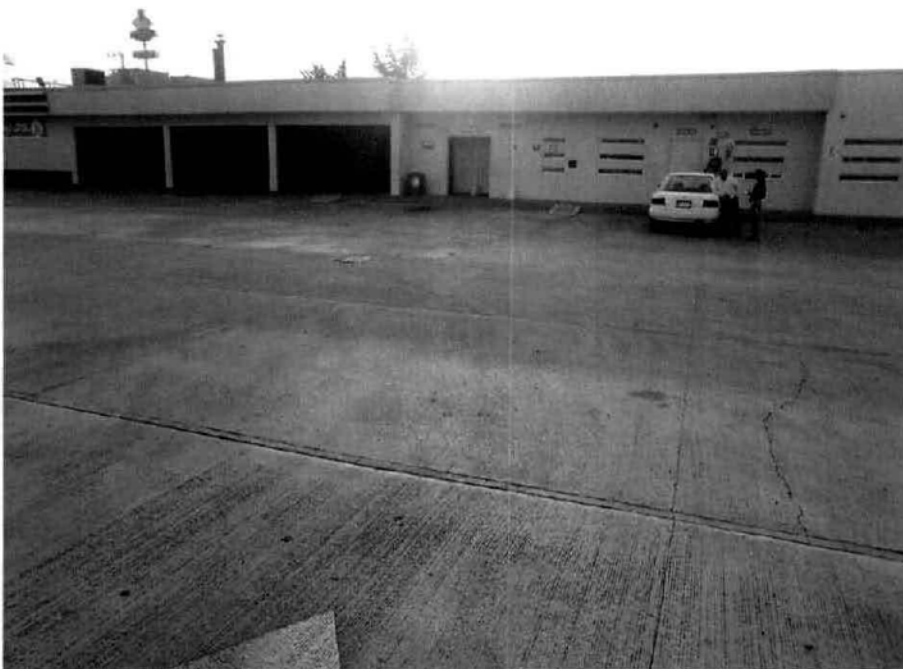
Figura 4. Área de oficinas de la estación de servicio.
