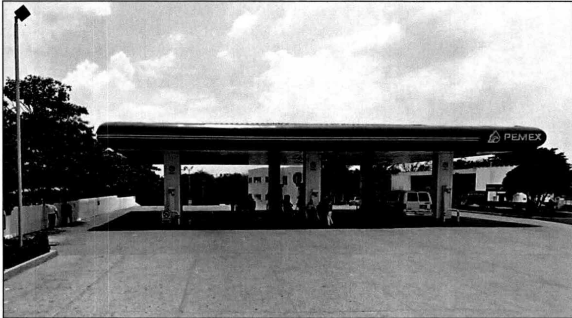
Imagen 1. Estación de servicio.
