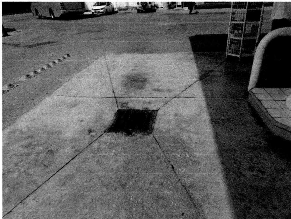
6.-Se observa la rejilla del sistema de drenaje de aguas aceitosas de la zona de dispensarios.
