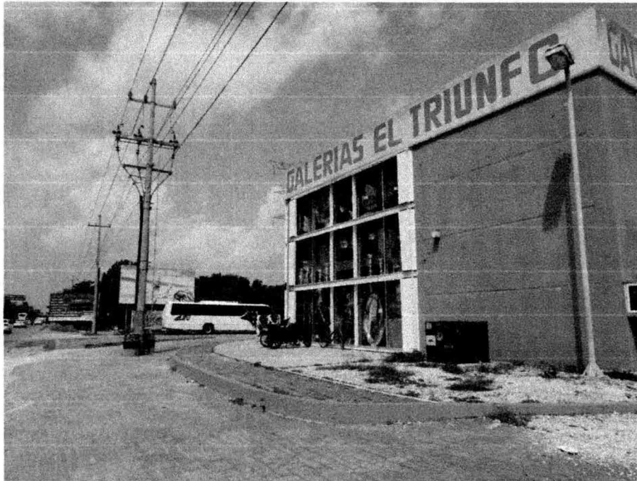
21.- Al oeste de la estación se observa un callejón y posteriormente un local comercial y la Avenida Universidades.
