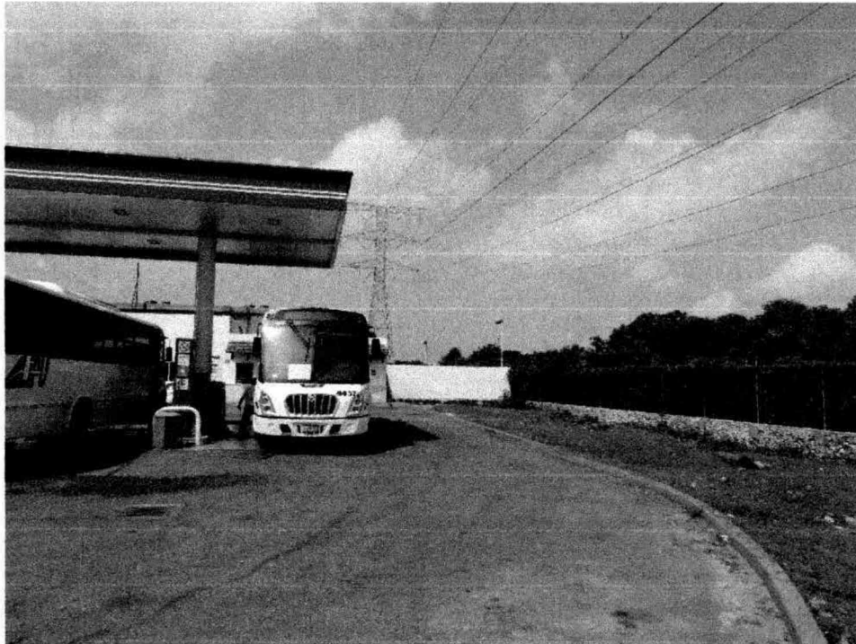
16. Se observa el área de rodamiento que se incrementará para la circulación de los camiones hacia el nuevo dispensario a la derecha de la foto.
