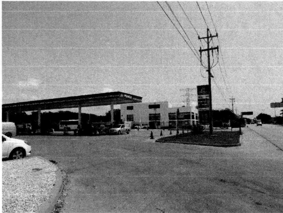
2.-El acceso al predio del proyecto es por la carretera federal 307 Chetumal-Puerto Juárez por avenida universidades, se observa la entrada y salida a la estación de servicio.
