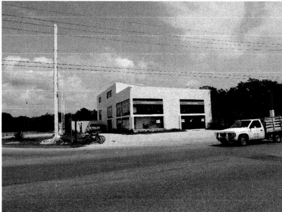
20.-Colindancia este, a la izquierda se encuentra la estación de servicio No. 11030 y a la derecha se encuentra comercio particular.
