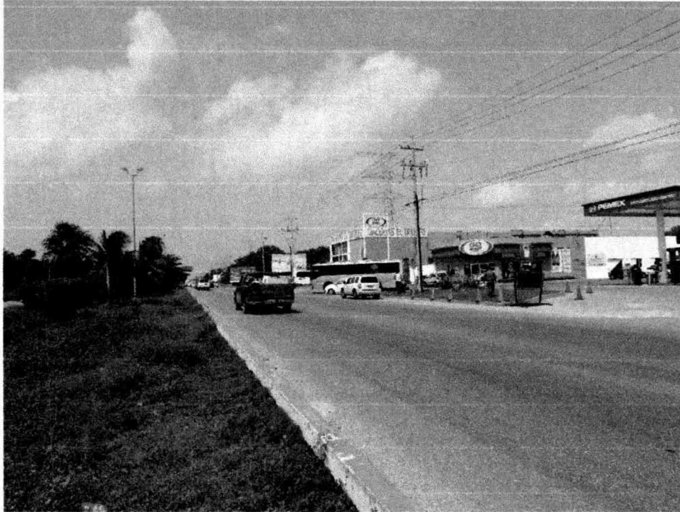
19.-Colindancia sur, se observa la carretera federal Chetumal-puerto Juárez por avenida universidades y a la derecha se encuentra la estación de servicio No. 11030.
