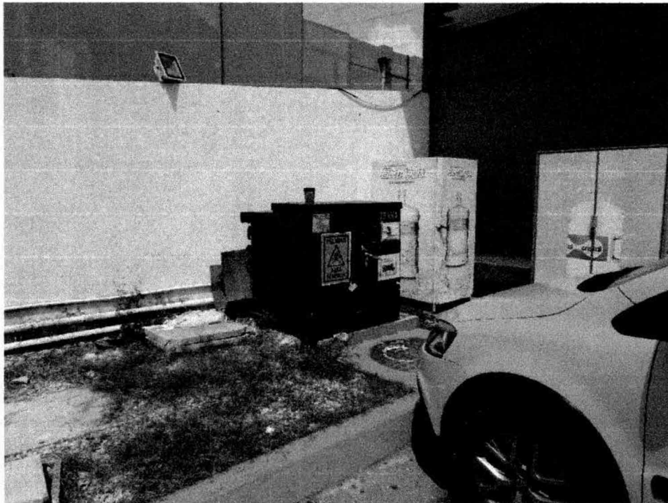
14.-En el costado oeste hay un área verde y la subestación eléctrica de 75 KVA.
