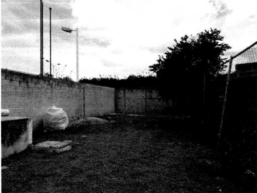
17.- Como parte del proyecto, en esta del predio se construirán baños para choferes.
