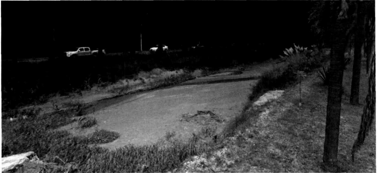
FOTOGRAFIA 13. CANAL DE AGUAS PLUVIALES DE AVENIDA PATRIA. FUENTE AP CONSULTORES
