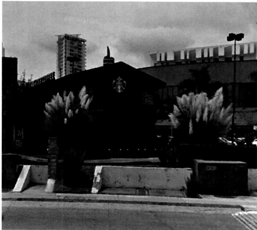
FOTOGRAFÍA 5.- PLAZA COMERCIAL ANDARES A 240 METROS DE LA ESTACIÓN DE SERVICIO CONTADOS DEL EJE DE LA ZONA DE TANQUES A LÍMITE DE PREDIO
