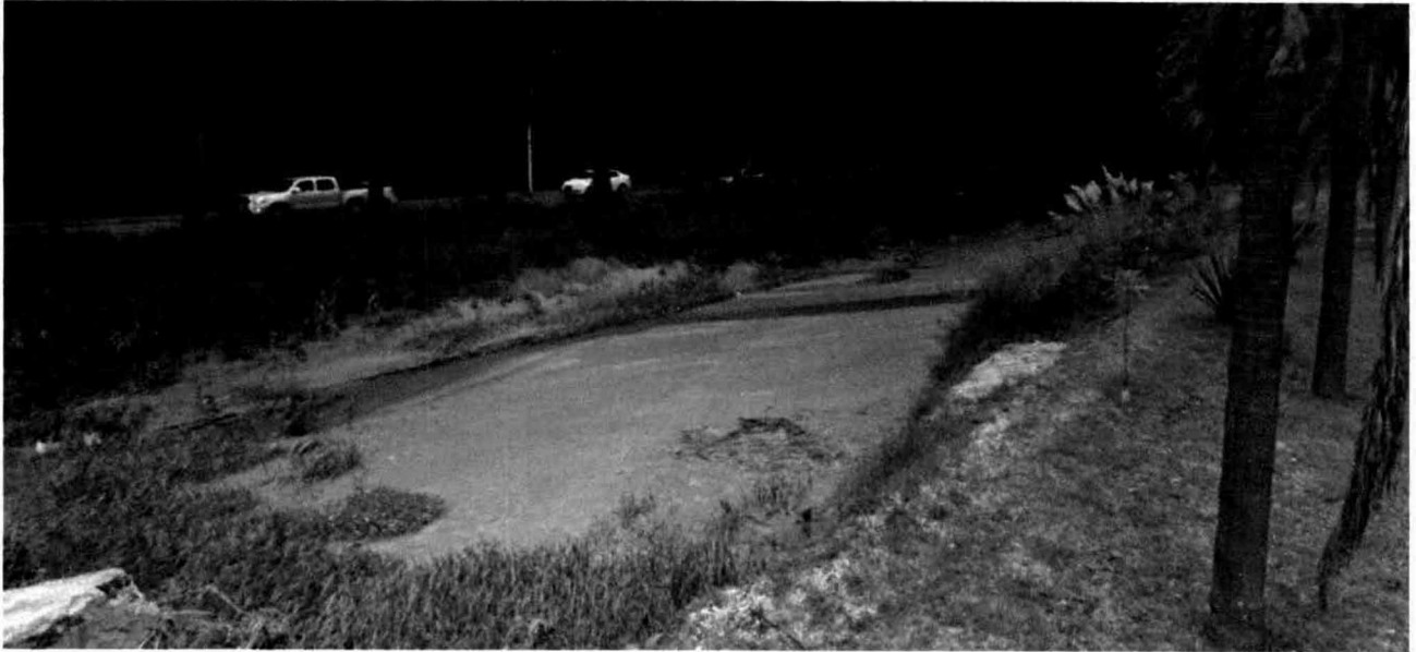
FOTOGRAFIA 8. CANAL DE AGUAS PLUVIALES DE AVENIDA PATRIA. FUENTE AP CONSULTORES
