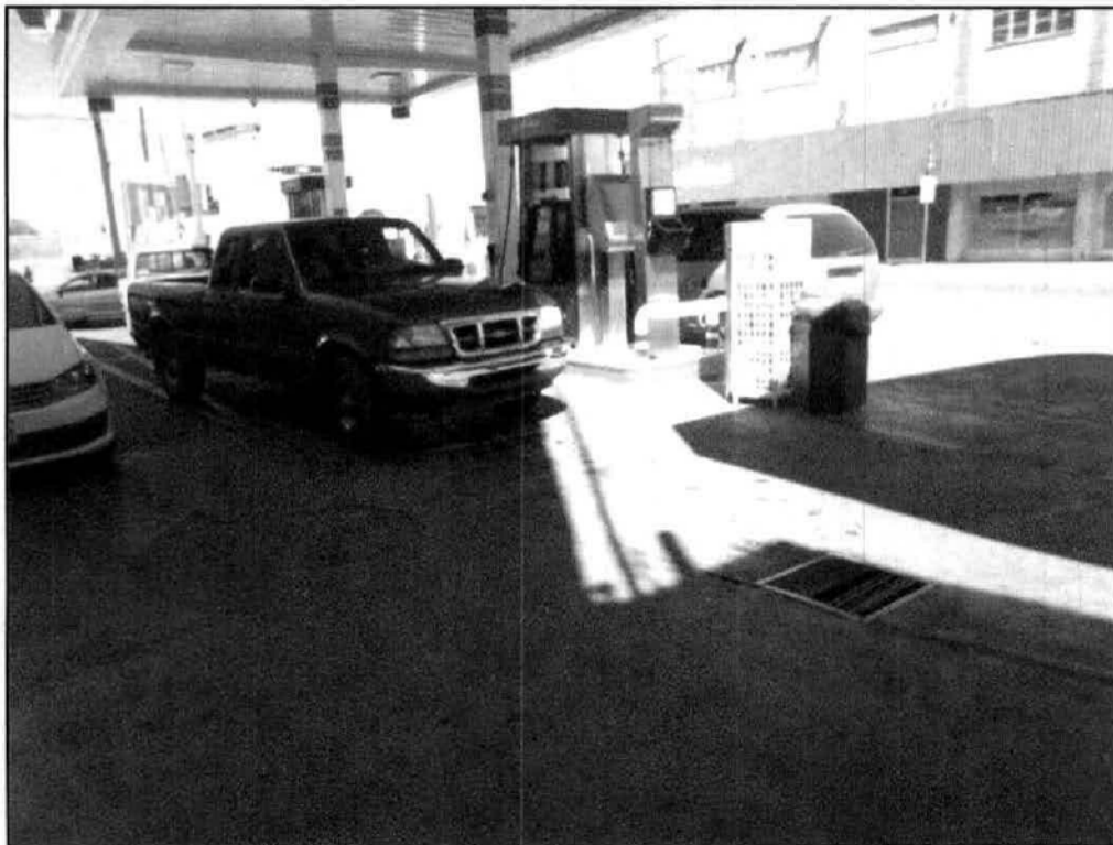
Imagen 4. Rejillas para la trampa de grasas en la estación de servicio.
