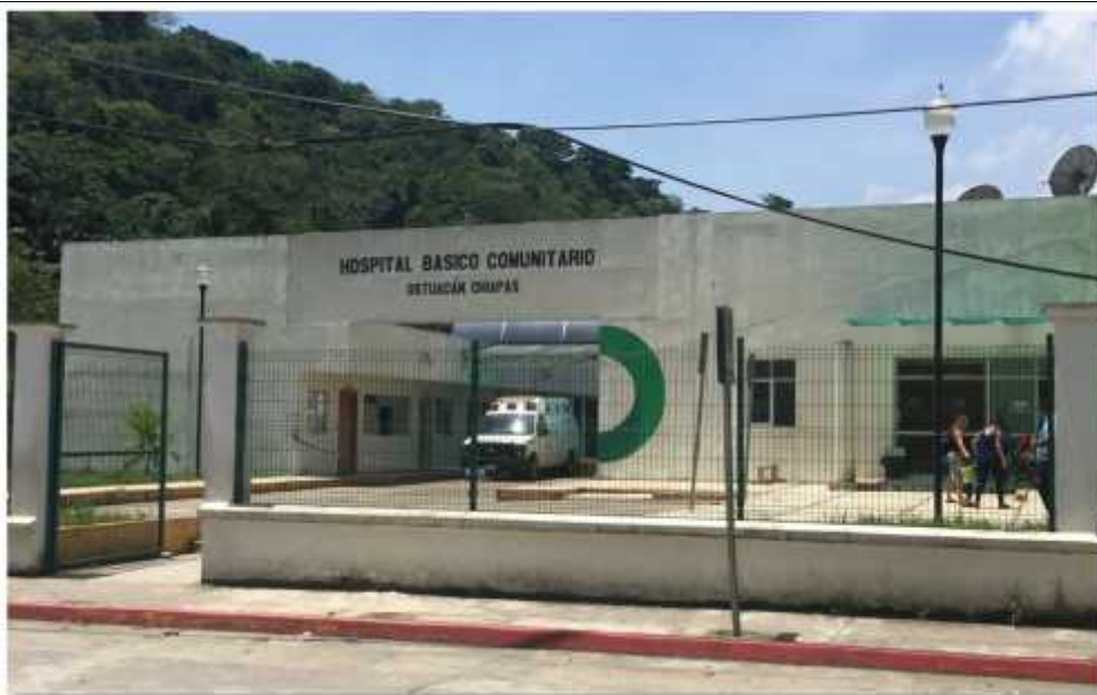
Fotografía 3.27 Hospital Básico Comunitario Ostuacán.
