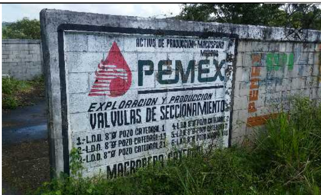
Fotografía 3.10 Válvulas de seccionamiento
