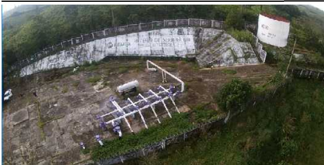
Fotografía 3.11 Vista Aérea de la batería de separación Catedral
