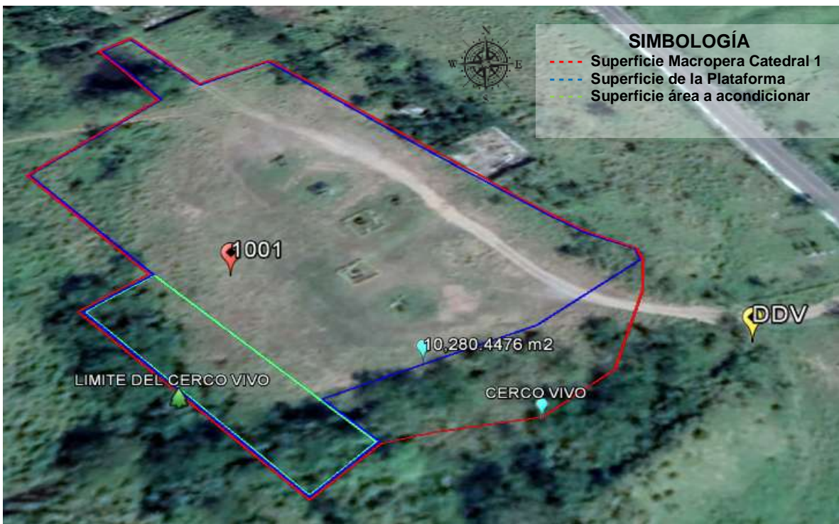
Figura 1.5 Superficie de la plataforma (marcado en azul) a emplear de 10,280.4476 m 2 para distribuir equipos de perforación y sus componentes, al interior de la Macropera Catedral 1.
