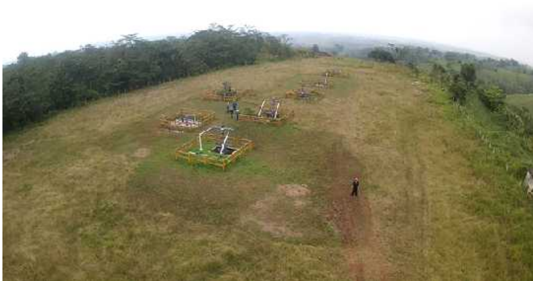
Fotografía 3.16 Vista Aérea de la Macropera 15
