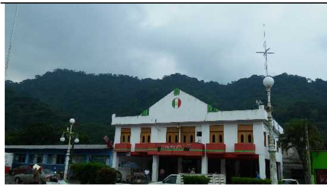
Fotografía 3.22 Palacio municipal de Ostuacán
