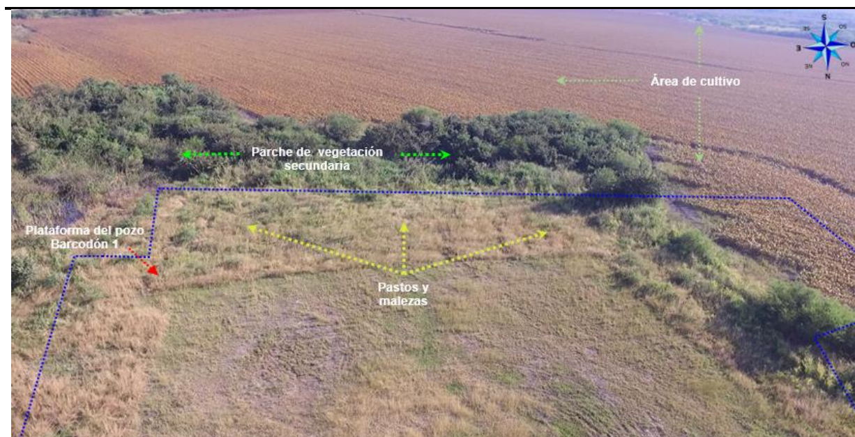
Figura 19. Área sur de la plataforma para la perforación del pozo Barcodón 1.
