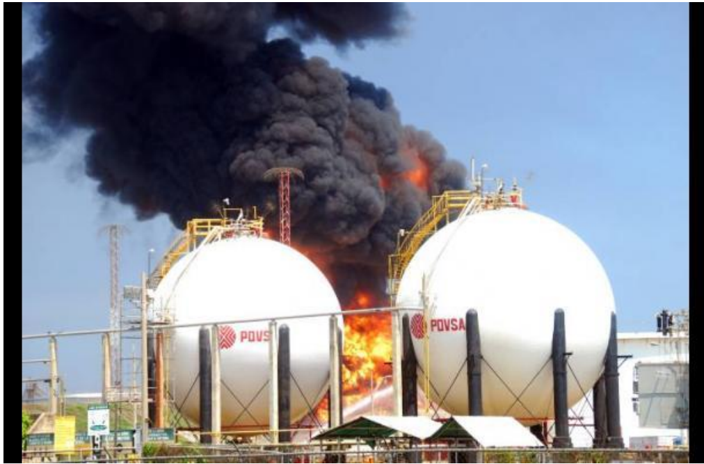
Fig. 14. Accidentes con combustibles
