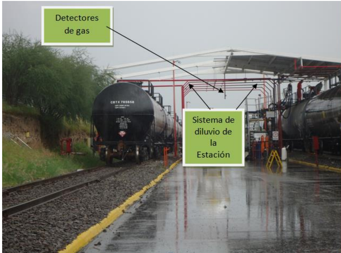
Figuras 32. Estación equipada para trasvase de Diésel y Gasolina.
