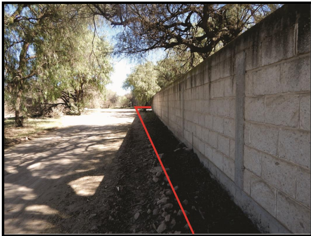
Figura 6. Tramo paralelo al camino que comunica a la localidad de La Luz de San Miguelito correspondiente a 663.55 m de la City Gate hasta el primer codo de 90°.
