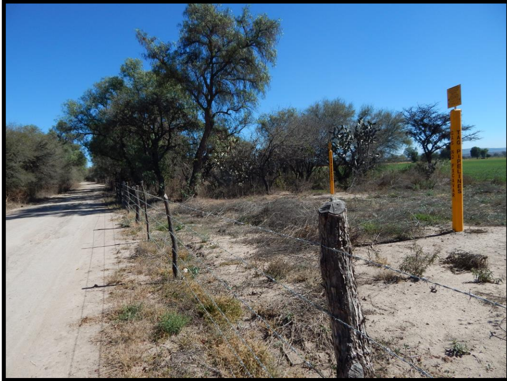
Figura 4. Área de interconexión y camino de acceso a la localidad de La Luz de San Miguelito..
