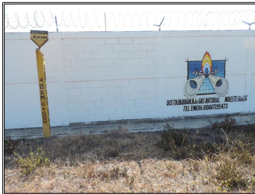
Foto VIII.2 Punto de inserción del ducto al sistema de ductos administrado por Distribuidora de Gas Natural del Noroeste, S.A. de C.V. (DGNN)
