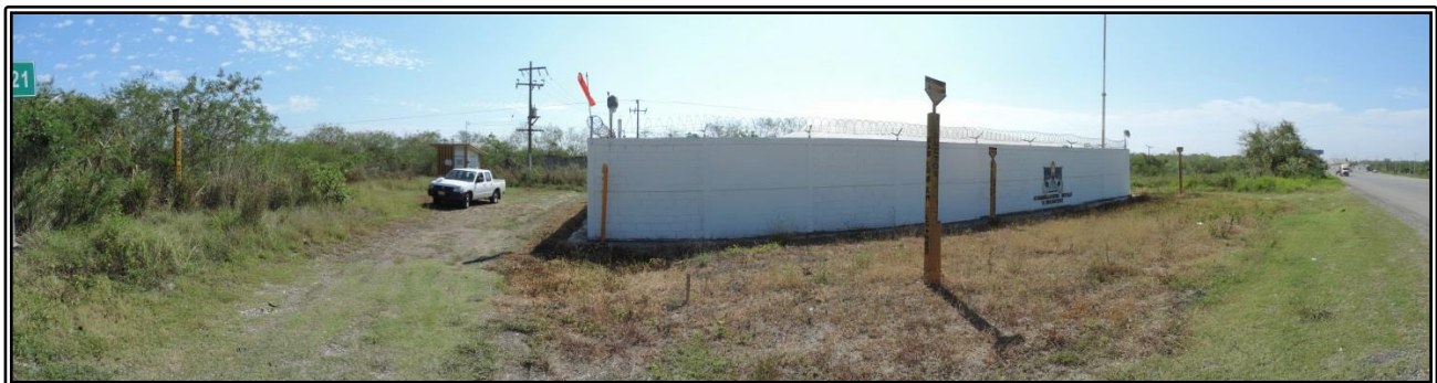
Foto VIII.3 Panorámica de las instalaciones de DGNN en donde se realizará la conexión y se instalará la ERM Dynasol. Vista hacia el norte.
