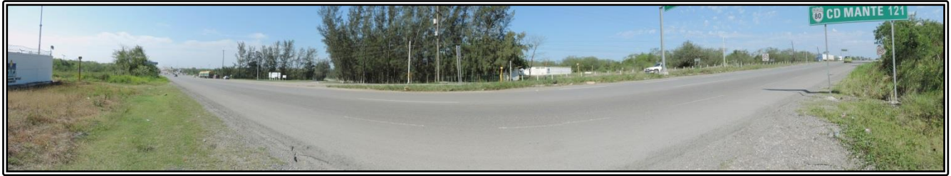
Foto VIII.1 Panorámica Frente al punto donde se ubicará la ERM Dynasol. Vista hacia el sur.
