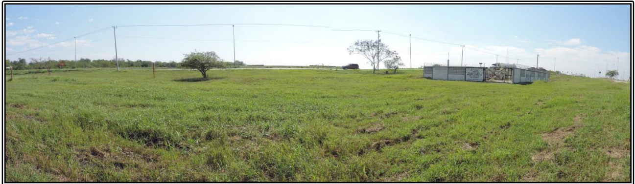
Foto VIII.5 Panorámica que muestra la válvula de PEMEX que se encuentra a un costado del puente. Vista hacia el sureste.
