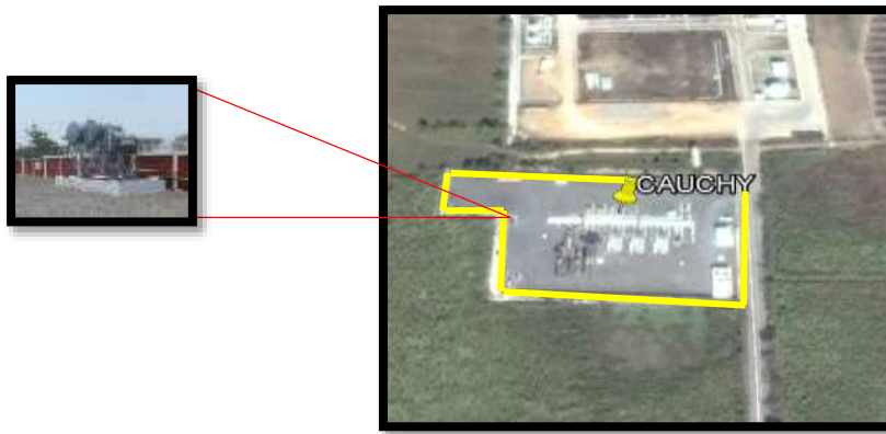
Imagen 2 TANQUE DE ACEITE
