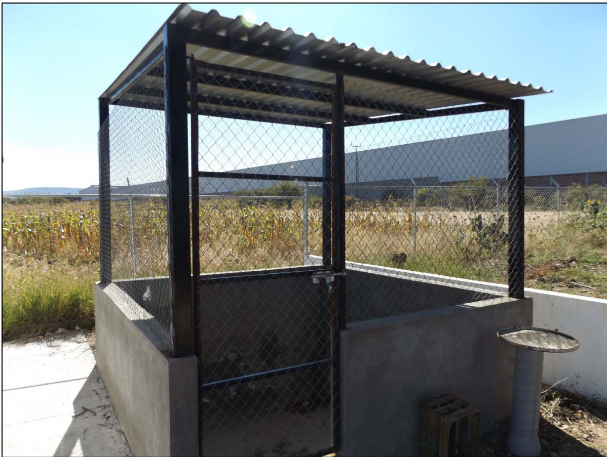
Figura II.15. Almacén de residuos peligrosos en el sitio del proyecto.
