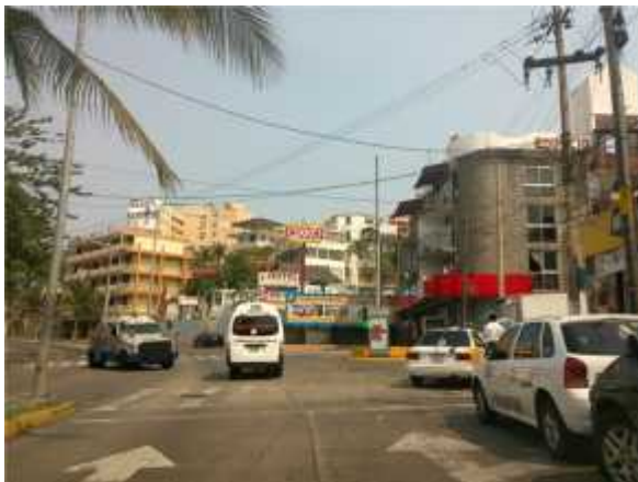
Foto 27. 16° 50' 26,68" – 99° 54' 46,09" Infraestructura urbana existente sobre la Av. Costera por donde quedará instalada la red de gas natural.
