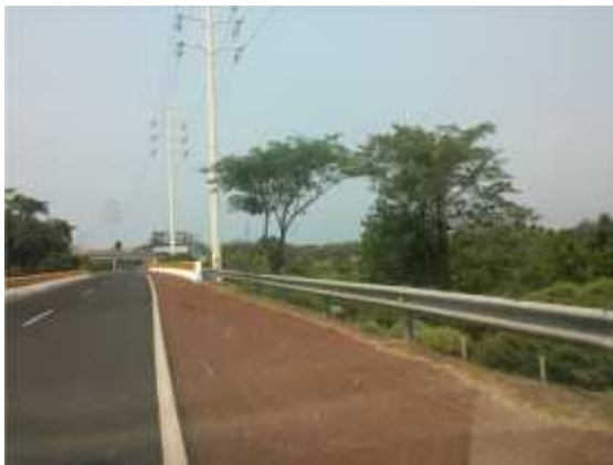
Foto 9. 16° 47' 55,32 – 99° 47' 33,42' Puente carretero que cruza un río para conducción de aguas residuales.
