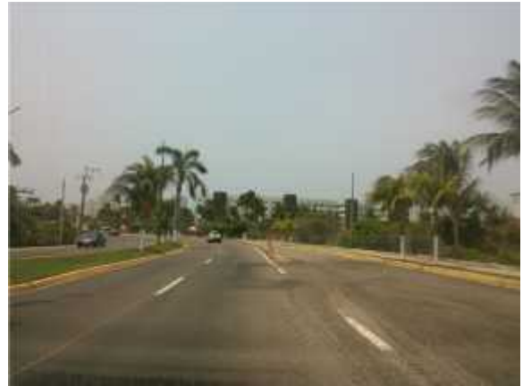
Foto 14. 16° 46' 30,33" – 99° 46' 39,50" Vista de Noreste a Suroeste del Blvd. Barra Vieja.
