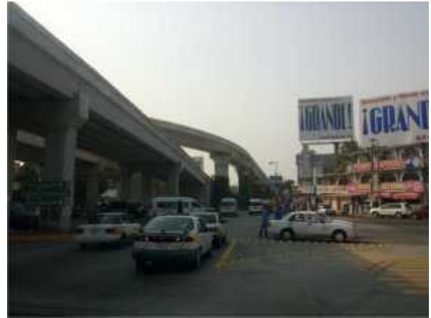
Foto 18. 16° 48' 21,59" – 99° 49' 34,29" Vista de del Blvd. De las Naciones en el cruce con la carretera Coyouca – Puerto Marqués. .
