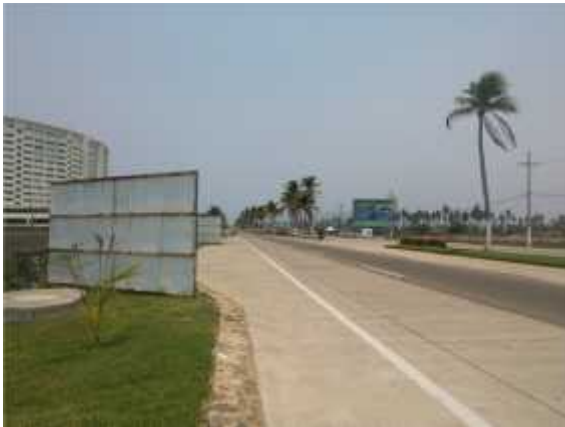
Foto 31. 16° 44' 04,74" – 99° 44' 14,18" Vista de Sureste a Noroeste del Blvd. Barra Vieja.
