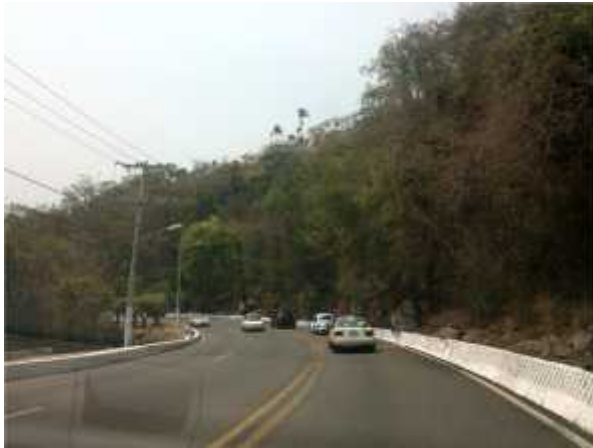
Foto 1. 16° 49' 26,75" – 99° 51' 38,08" Carretera Escénica por donde se instalará el gasoducto de 8" D.N.
