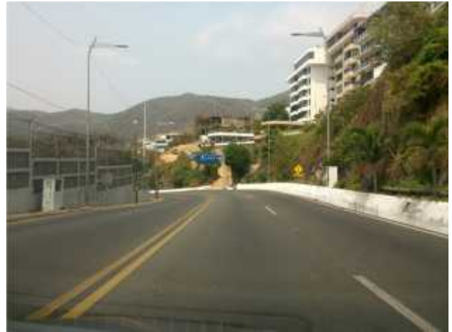
Foto 2. 16° 50' 12, 25" – 99° 51' 03,70" Carretera Escénica por donde se instalará el gasoducto de 8" D.N.
