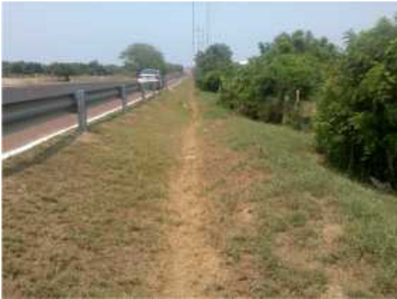
Foto 5. 16° 48' 06,58" – 99° 47' 20,78" Derecho de vía del Viaducto Diamante por donde quedará instalado en gasoducto de 8" D.N.
