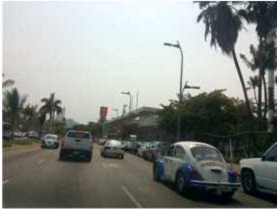
Foto 13. 16° 51' 32,51" – 99° 53' 21,77" Infraestructura urbana existente sobre la Av. Costera por donde quedará instalada la red de gas natural.
