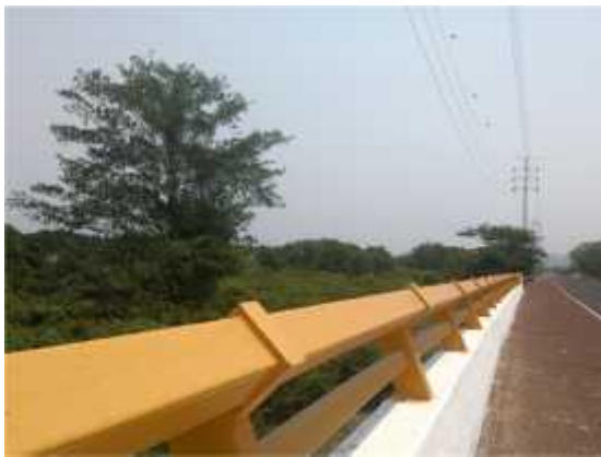
Foto 11. 16° 47' 53,45" – 99° 47' 35,56" Puente carretero que cruza un río para conducción de aguas residuales.
