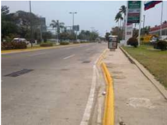
Foto 5. 16° 48' 10,40" – 99° 49' 21,81" Vista de Noroeste a Sureste del Blvd. De las Naciones.
