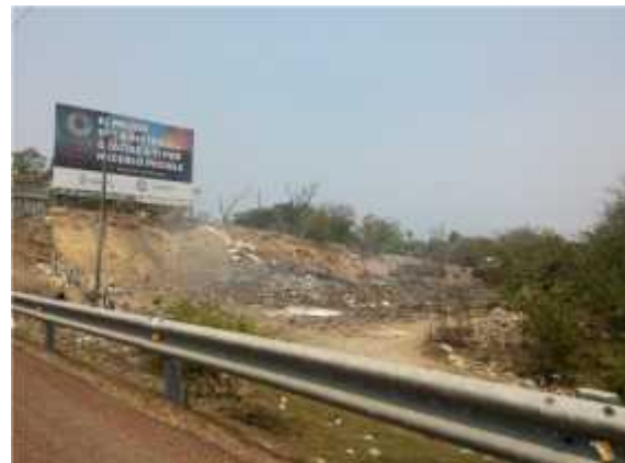
Foto 12. 16° 47' 52,11" – 99° 47' 37,68" Presencia de residuos sólidos a un costado del derecho de vía del Viaducto Diamante.
