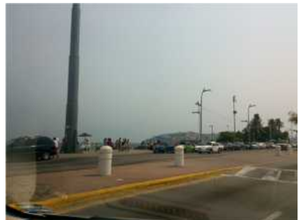
Foto 12. 16° 51' 39,73" – 99° 53' 14,19" Infraestructura urbana existente sobre la Av. Costera por donde quedará instalada la red de gas natural.
