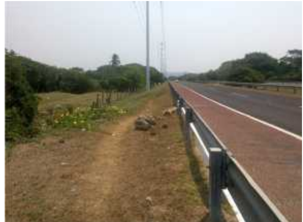
Foto 2. 16° 48' 06,71" – 99° 47' 20,68" Derecho de vía del Viaducto Diamante por donde quedará instalado en gasoducto de 8" D.N.
