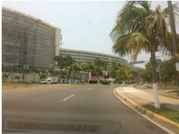
Foto 13. 16° 46' 32,33" – 99° 46' 38,86" Vista de Noreste a Suroeste del Blvd. Barra Vieja.
