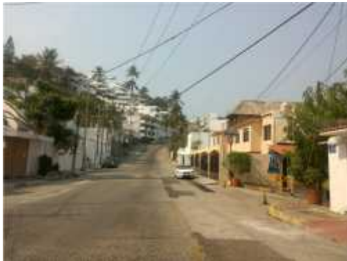
Foto 35. 16° 50' 13,99" – 99° 55' 01,83" Infraestructura urbana existente sobre la Av. Adolfo López Mateos por donde quedará instalada la red de gas natural.
