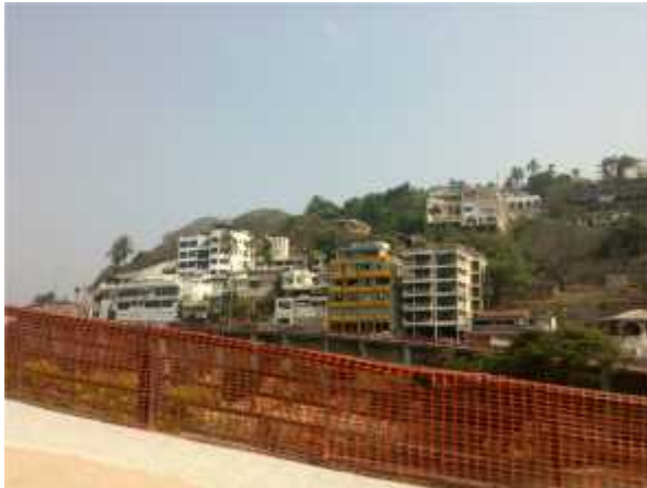
Foto 25. 16° 50' 32,59" – 99° 54' 52,73" Infraestructura urbana existente sobre la Av. Costera por donde quedará instalada la red de gas natural.
