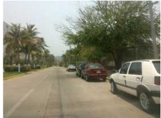
Foto 18. 16° 46' 59,75" – 99° 48' 19,57" Vialidad interna del campo de golf por donde quedará instalado el SDGN.
