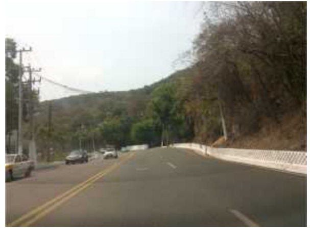
Foto 26. 16° 48' 57,27" – 99° 50' 31,85" Vista de la carretera Escénica por donde se ubicará el gasoducto de 8" D.N.
