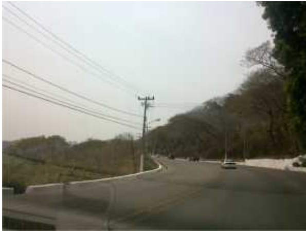
Foto 17. 16° 48' 19,21" – 99° 49' 52,46" Vista de la carretera Escénica por donde se ubicará el gasoducto de 8" D.N.
