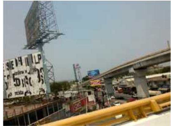
Foto 14. 16° 48' 21,10" – 99° 49' 33,76" Puentes vehiculares sobre la Carretera Cayaco – Puerto Marqués.
