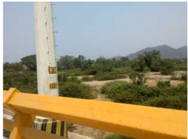
Foto 10. 16° 47' 53,46" – 99° 47' 35,31" Puente carretero que cruza un río para conducción de aguas residuales.
