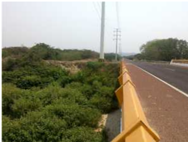
Foto 7. 16° 47' 59,02" – 99° 47' 29,57" Puente carretero que cruza un río para conducción de aguas residuales.
