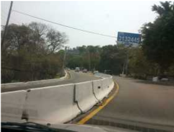
Foto 15. 16° 48' 25,48" – 99° 49' 37,17" Vista de la carretera Escénica por donde se ubicará el gasoducto de 8" D.N.
