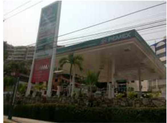
Foto 22. 16° 50' 39,00" – 99° 54' 42,17" Estación de Servicio de Pemex existente sobre la Av. Costera por donde se ubicará el gasoducto de 8" D.N.
