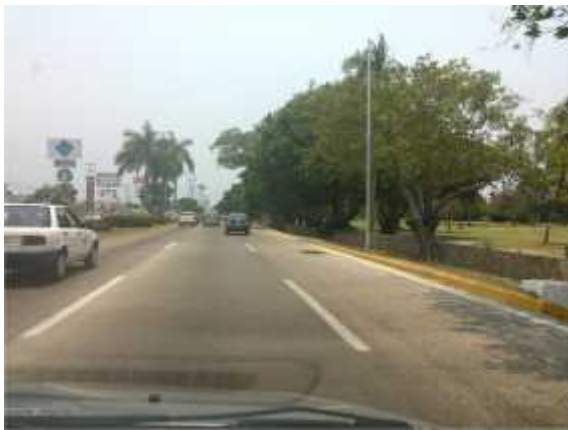
Foto 37. 16° 47' 50,93" – 99° 48' 49,73" Vista de Noroeste a Sureste del Blvd. De las Naciones.
