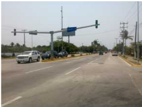
Foto 7. 16° 45' 54,98" – 99° 46' 42,48" Vista de Noroeste a Sureste del Blvd. De las Naciones.
