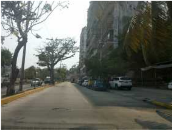
Foto 21. 16° 50' 40,58" – 99° 54' 34,04" Infraestructura urbana existente sobre la Av. Costera por donde quedará instalada la red de gas natural.
