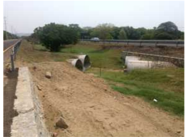
Foto 6. 16° 48' 05,78" – 99° 47' 21,09" Derecho de vía del Viaducto Diamante por donde quedará instalado en gasoducto de 8" D.N.
