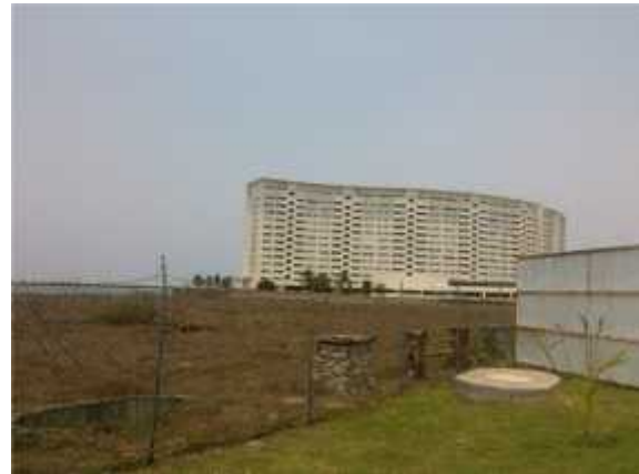
Foto 32. 16° 44' 04,75" – 99° 44' 14,51" Localización de cliente potencial para suministro de gas natural.
