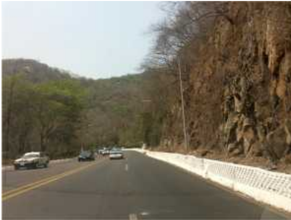
Foto 25. 16° 48' 33,95" – 99° 50' 07,28" Vista de la carretera Escénica por donde se ubicará el gasoducto de 8" D.N.
