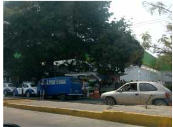
Foto 14. 16° 51' 31,55" – 99° 53' 32,73" Infraestructura urbana existente sobre la Av. Costera por donde quedará instalada la red de gas natural.
