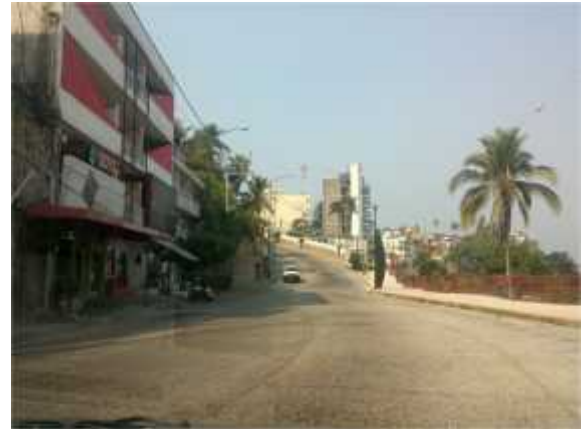
Foto 26. 16° 50' 31,02" – 99° 54' 56,01" Infraestructura urbana existente sobre la Av. Costera por donde quedará instalada la red de gas natural.
