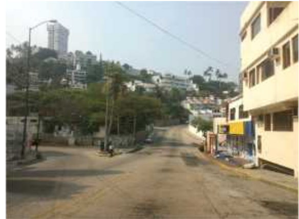
Foto 34. 16° 50' 23,05" – 99° 54' 58,91" Infraestructura urbana existente sobre la Av. Adolfo López Mateos por donde quedará instalada la red de gas natural.
