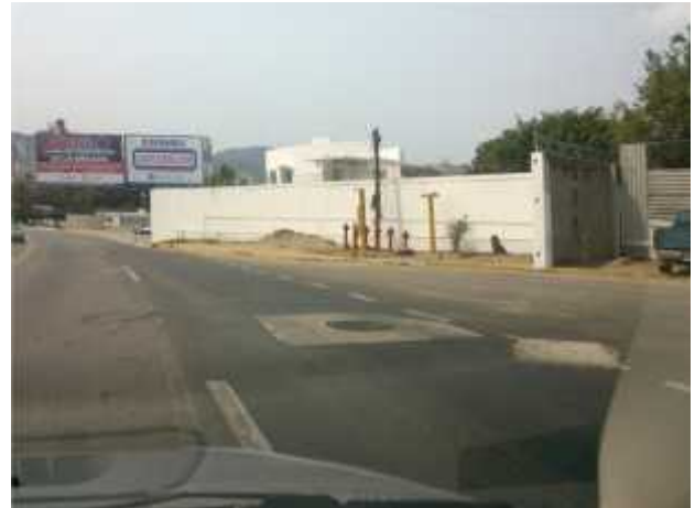
Foto 4. 16° 50' 30,85" – 99° 50' 49,38" Carretera Escénica por donde se instalará el gasoducto de 8" D.N.
