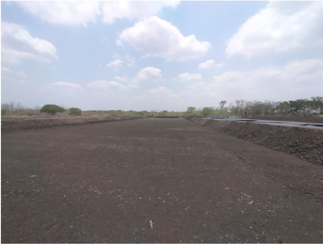
Fotografía 7. Conformación de celdas.
