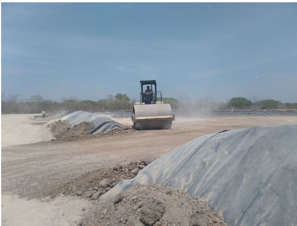
Fotografía 5. Conformación de celdas.
