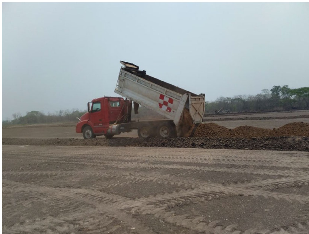
Fotografía 6. Conformación de celdas.
