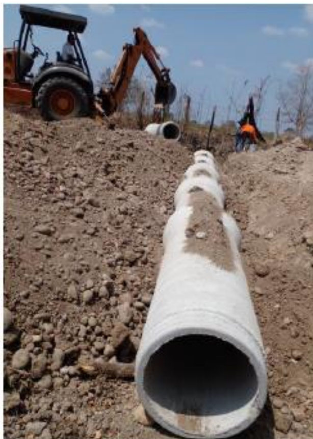
Fotografía 8. Zanjales para instalación de drenaje pluvial Fotografía 9. Tubería para drenaje pluvial.
