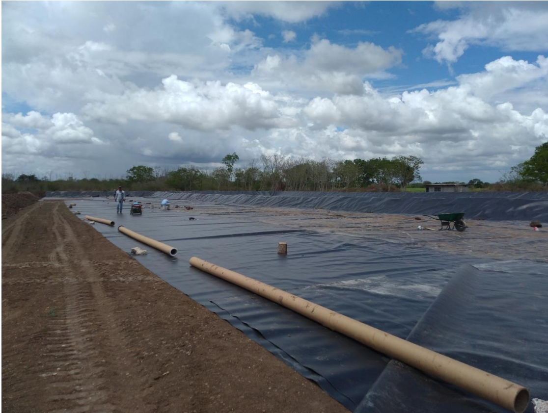
Fotografía 4. Conformación de celdas.
