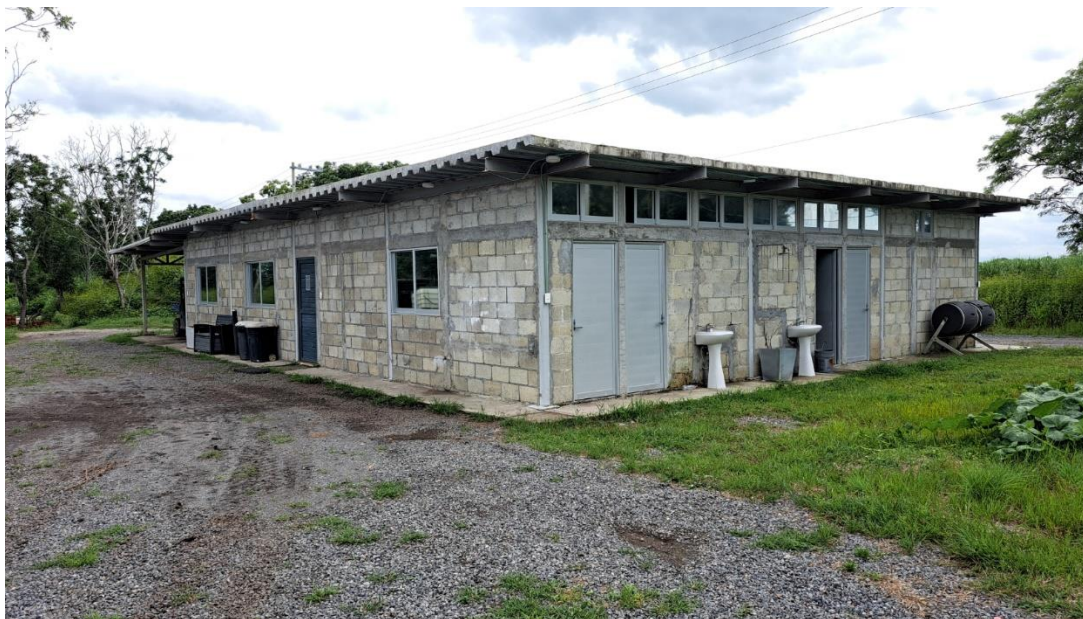
Fotografía 1. Oficinas y sanitarios ubicados en la superficie contigua al Área 1.
