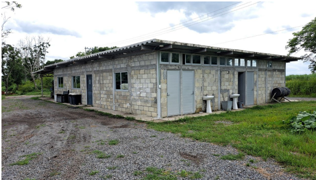
Figura 15 Oficinas y sanitarios ubicados en la superficie contigua al Área 1.
