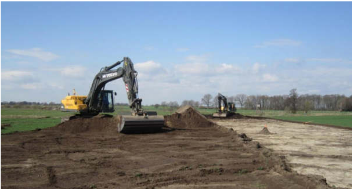
Figura II.13. Remoción de la capa vegetal.
