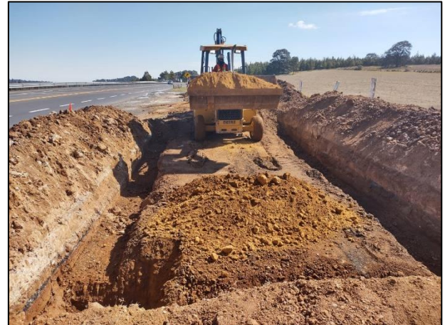
04. Se colocó una capa de arcilla sobre la base de la celda provisional con apoyo de retroexcavadora.
