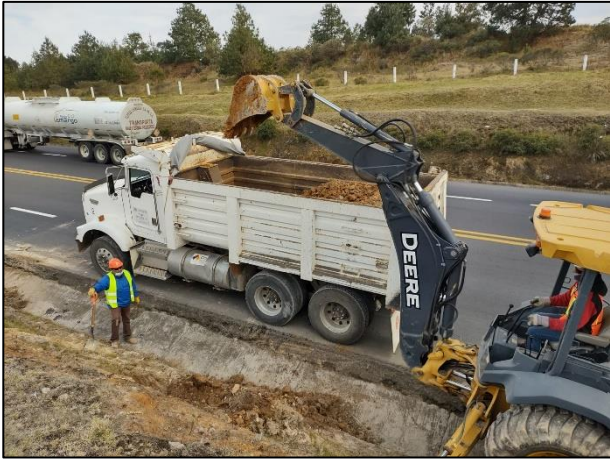
13. Actividades de extracción en el sitio. El material fue colocado en camión de volteo para su posterior acarreo a celda provisional.
