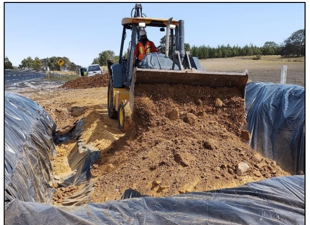
16. Distribución del material edáfico extraído dentro de la celda provisional.
