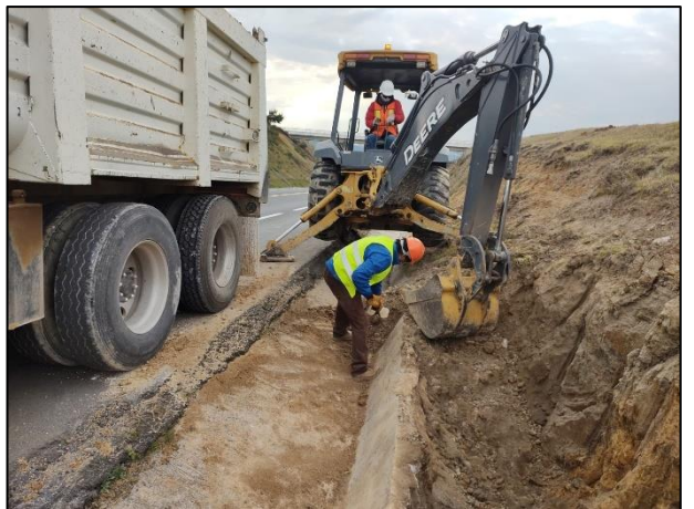
12. Con apoyo de retroexcavadora se realizaron las actividades de extracción en el sitio, originándose las Fosas de Excavación "A" y "B".
