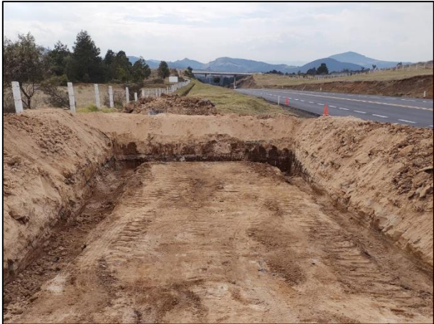
03. Se llevó a cabo la construcción de las canaletas para la captación de lixiviados.
