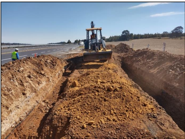
05. Con maquinaria pesada se distribuyó la capa de arcilla sobre la base de la celda.
