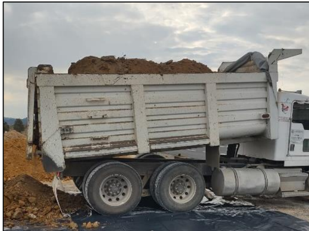
15. El material edáfico extraído fue colocado dentro de la celda provisional.
