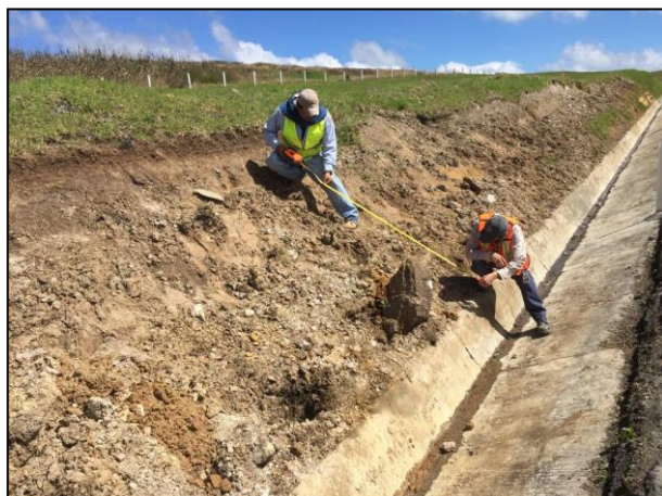
04. Con apoyo de cinta métrica se realizó la medición del Área Afectada correspondiente a la Fosa de Excavación "A".
