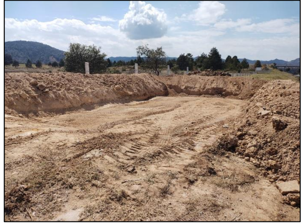
02. Con apoyo de retroexcavadora se construyeron los bordos perimetrales de la celda provisional.
