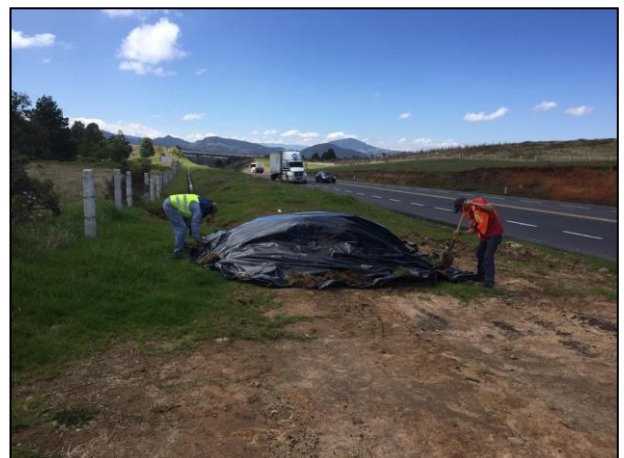
12. El material colocado por los cuerpos de auxilio fue resguardado en el derecho de vía y fue cubierto con una membrana de polietileno de alta densidad.
