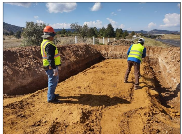
06. Se realizó la compactación de la capa de arcilla con apoyo de vibro compactador manual.
