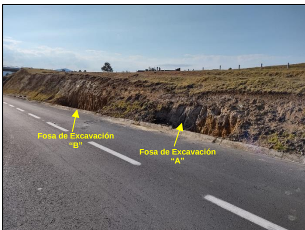
17. Vista general de las Fosas de Excavación "A" y "B".
