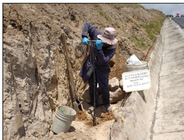
06. Se realizó la tomade muestras duplicado para el aseguramiento de la calidad de estas. Toma de muestra dentro de la Fosa de Excavación "B".
