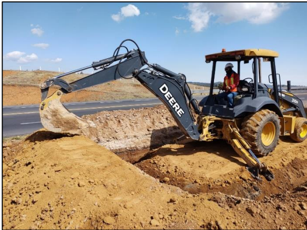
07. Compactación de bordos perimetrales con apoyo de retroexcavadora.
