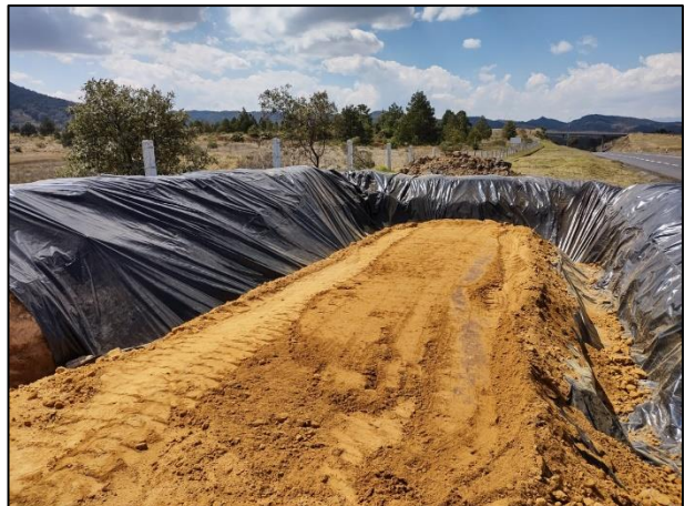
10. Se realizó la distribución de la segunda capa de arcilla.
