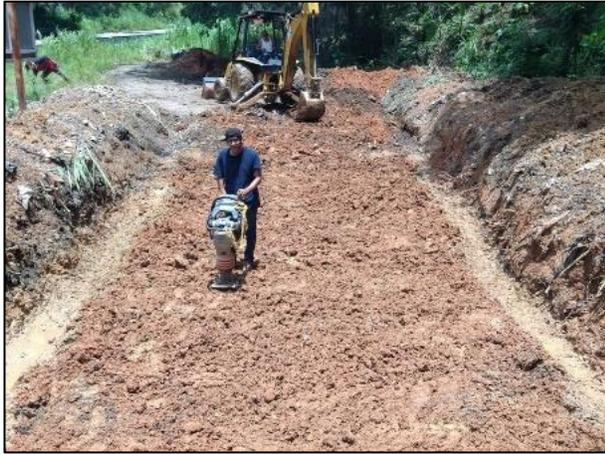
13. Compactación de la capa de arcilla, utilizando un vibro compactador manual.
