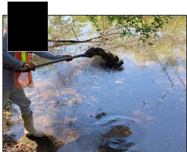
18. Se aplicó musgo absorbente en el cuerpo de agua intermitente (represa) afectado.
