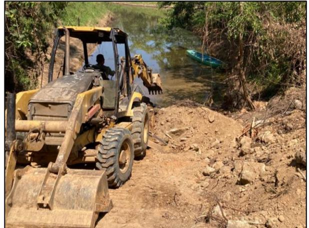
34. Con ayuda de una retroexcavadora, se realizó la extracción del material edáfico afectado con Diésel.
