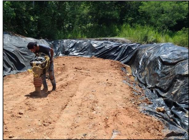
16. Se compactó la segunda capa de arcilla con apoyo de un vibro compactador manual.
