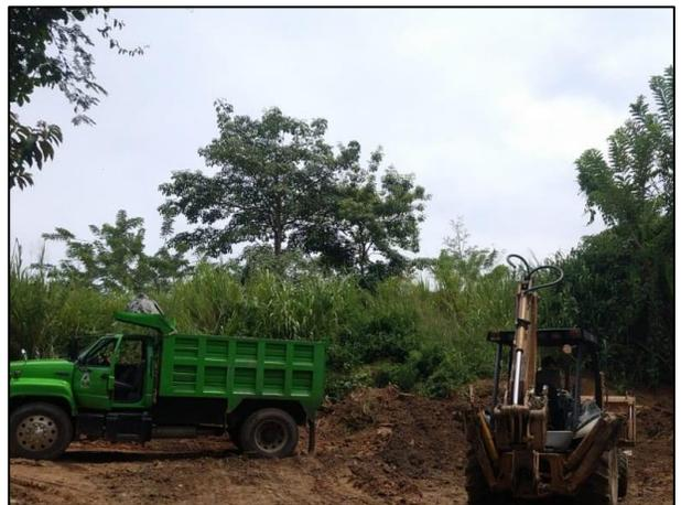
36. Acarreo del material edáfico afectado con Diesel para su depósito en la Celda Provisional.
