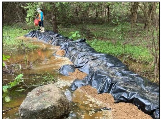
06. Barrera reforzada para realizar los trabajos de limpieza del del cuerpo de agua intermitente (represa).
