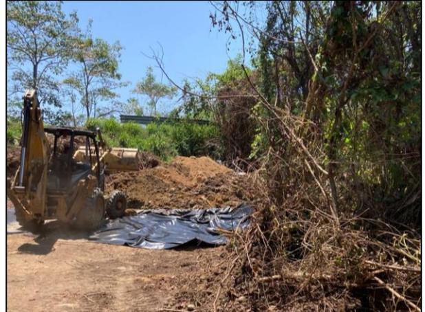
32. Se colocó el musgo absorbente sobre la membrana de polietileno de alta densidad para su posterior acarreo a la Celda Provisional.
