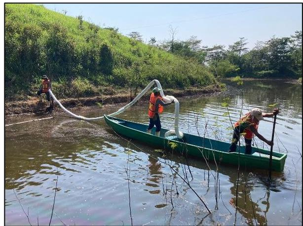
24. Colocación de cordones oleofílicos sobre el cuerpo de agua intermitente (represa) dañado.
