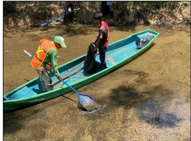
28. Retiro manual del musgo absorbente impregnado y colocación de éste en bolsas plásticas.
