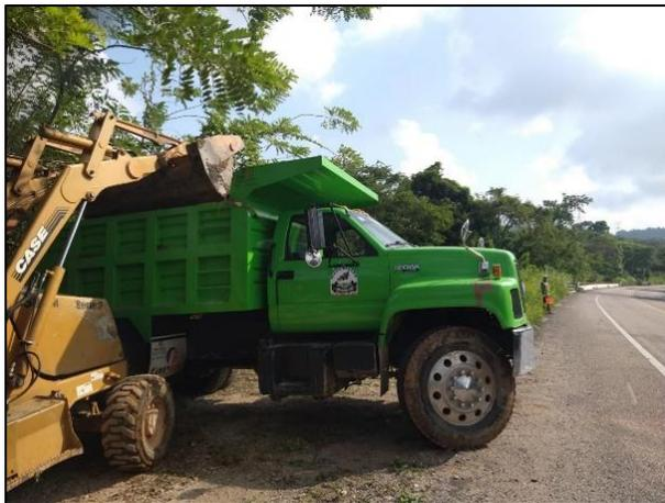
35. Con apoyo de un camión de volteo se acarreo y depositó el material edáfico afectado dentro de la Celda Provisional.
