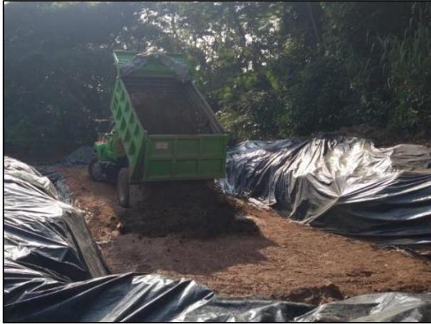
37. Depósito del material afectado dentro de la Celda Provisional.
