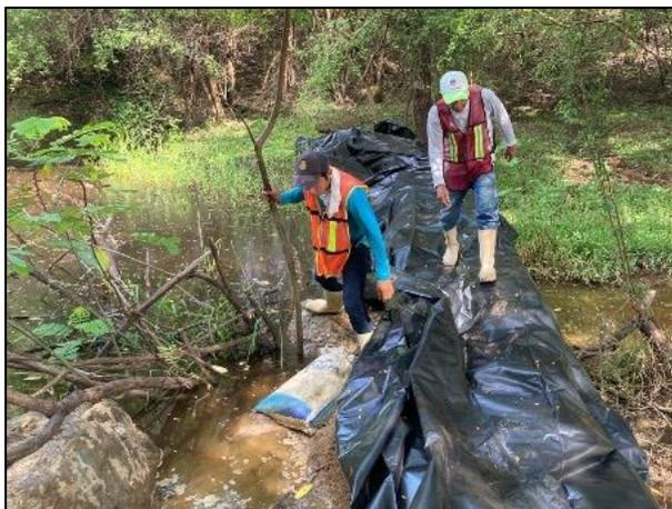
05. Reforzamiento de las barreras del cuerpo de agua intermitente (represa), con película de polietileno de alta densidad.
