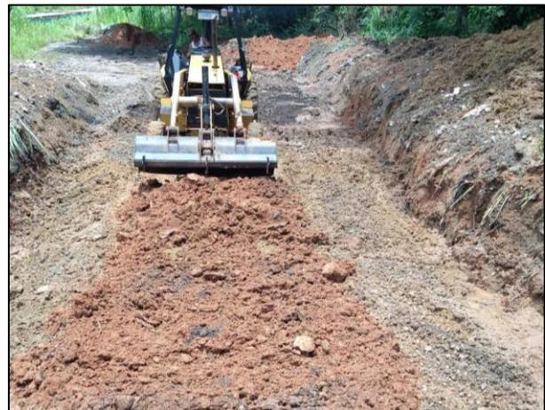
12. Colocación de la primera capa de arcilla en la base de la Celda Provisional.
