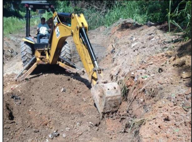
08. Construcción de los bordos de la Celda Provisional.
