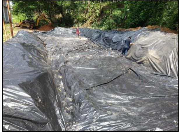
14. La Celda Provisional se cubrió con una película de polietileno de alta densidad, la cual fue unida mediante termosellado.
