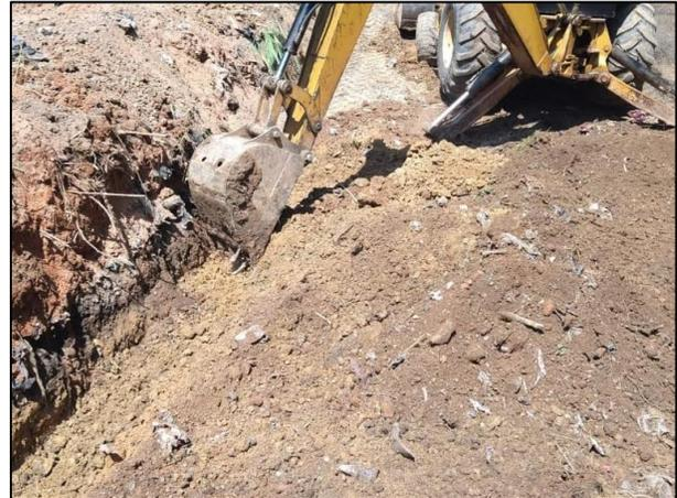
10. Construcción de canaletas para la captación de lixiviados.
