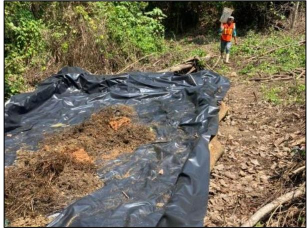
22. El material resultante de la limpieza fue colocado sobre película de polietileno de alta densidad para su posterior acarreo a la Celda Provisional.
