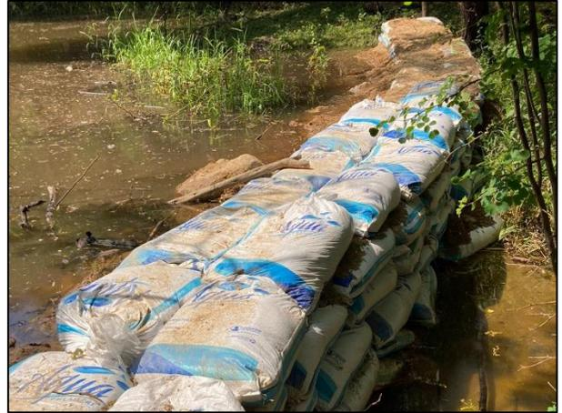
02. Barrera colocada por el propietario del predio particular para la acumulación de agua en el cuerpo de agua intermitente (represa).
