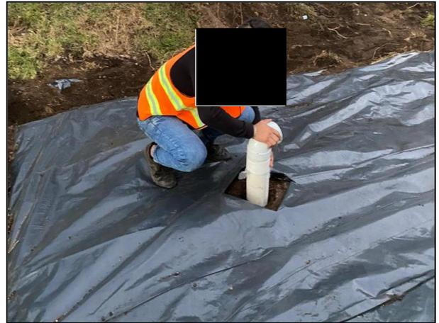
10. Se realizó la colocación de filtros de carbón activado para la captación de gases.
