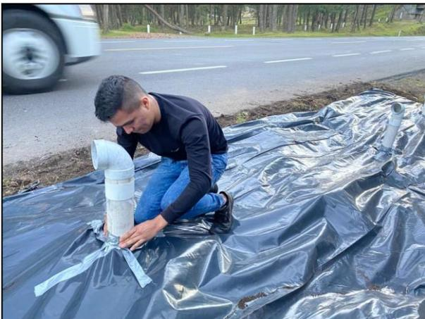
11. Se realizó la unión de la película de polietileno de alta densidad junto con los filtros de carbón activado con cinta industrial – metálica.
