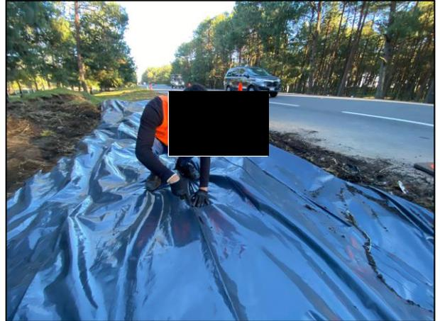
06. Se realizaron ranuras en la película de polietileno de alta densidad para la posterior colocación de los filtros de carbón activado.
