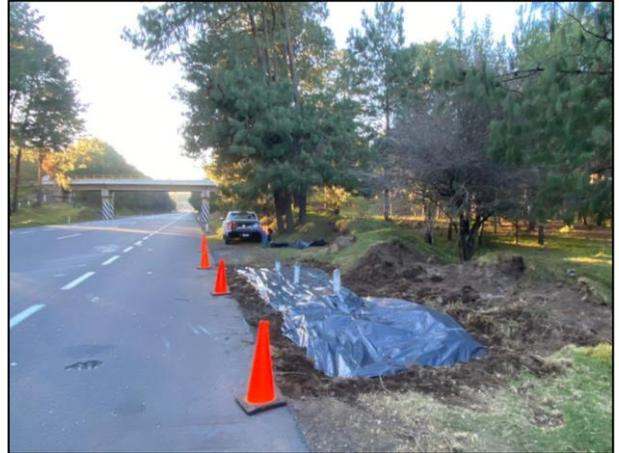
12. Área Afectada cubierta con película de polietileno de alta densidad y filtros de carbón activado.
