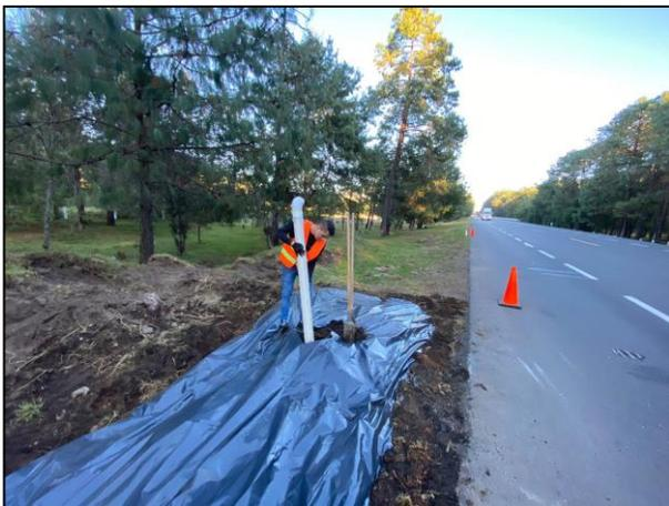
09. De manera manual se instalaron filtros de carbón activado dentro del Área Afectada.
