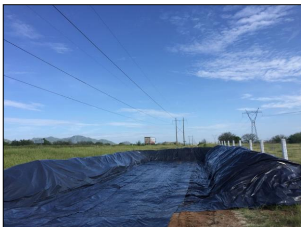
05. De igual manera la base de la Celda Provisional fue cubierta con película de polietileno de alta densidad.
