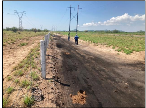
03. Al momento de la Visita Inicial se observó afectación sobre derecho de vía, contiguo a predio particular.
