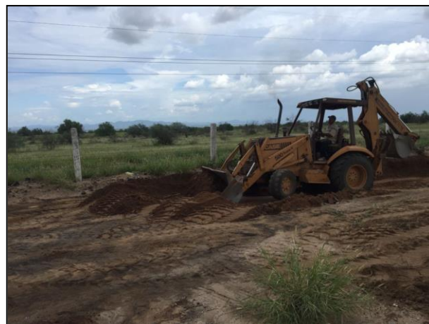
08. Extracción del material edáfico afectado con apoyo de retroexcavadora.
