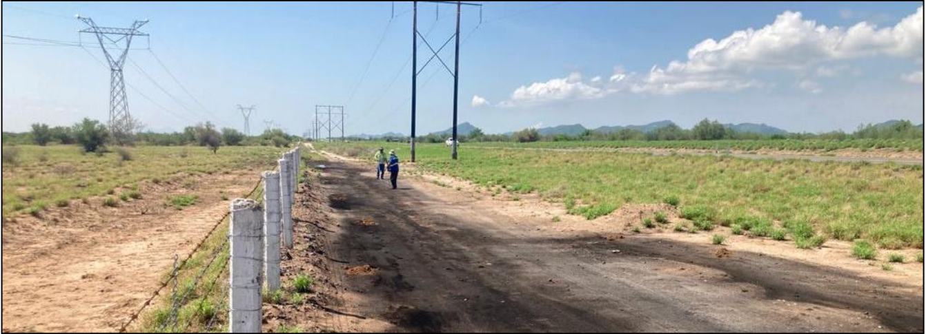
01. El sitio en estudio se encuentra en el Km. 30 de la Carretera No. 15 Hermosillo – Nogales, municipio de Hermosillo, estado de Sonora.
