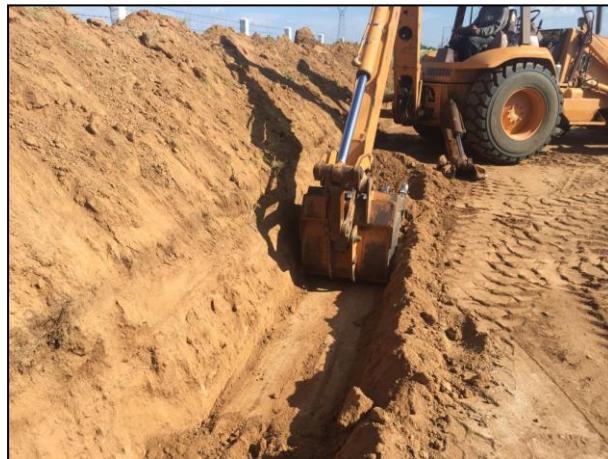
02. Construcción de canaleta para Celda Provisional.
