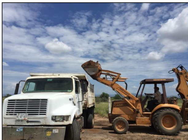
09. El material extraído se colocó en camión de volteo para su acarreo y depósito en Celda Provisional.
