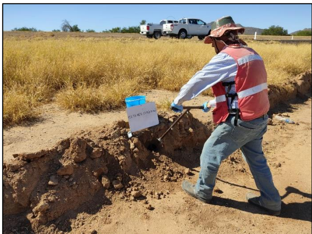
07. Toma de muestra en la pared del Área afectada.
