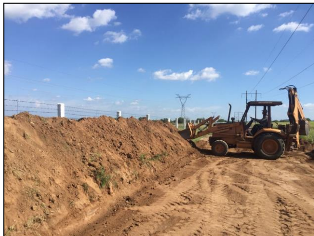
01. Se llevó a cabo la nivelación del terreno en el que se construyó la Celda provisional y se adecuaron los bordos de la misma con material edáfico libre de contaminantes.
