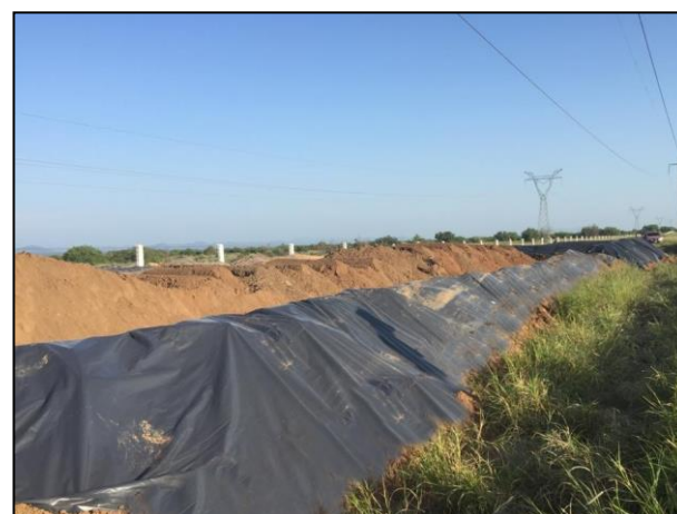
12. Vista de la Celda Provisional construida.
