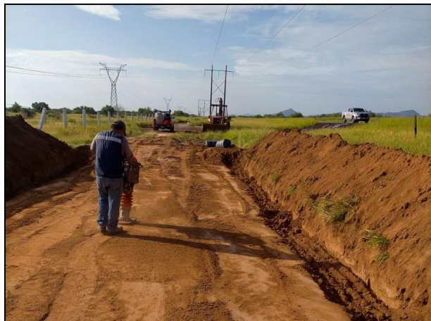
03. La base de la Celda se construyó con una capa de arcilla, misma que fue compactada.
