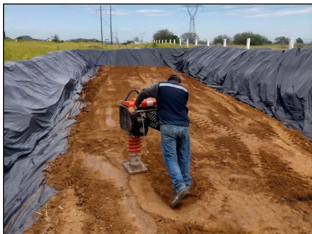
07. Depósito de segunda capa de arcilla sobre película de polietileno de alta densidad, misma que fue igualmente compactada.
