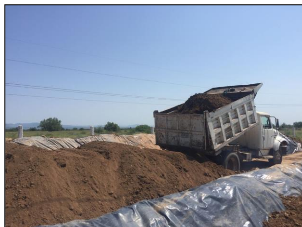
10. Depósito del material extraído, sobre película de polietileno de alta densidad para su posterior acarreo a la Celda Provisional.
