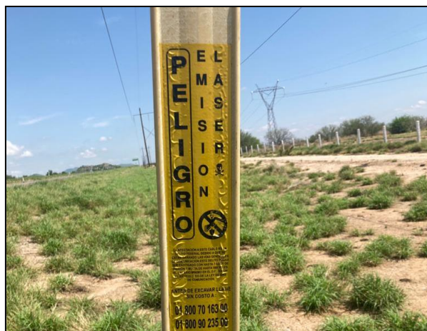
08. En el sitio se observa la presencia de postería de señalización de fibra óptica de TELMEX.
