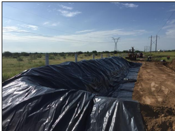
04. Los bordos de la Celda Provisional se cubrieron con película de polietileno de alta densidad.
